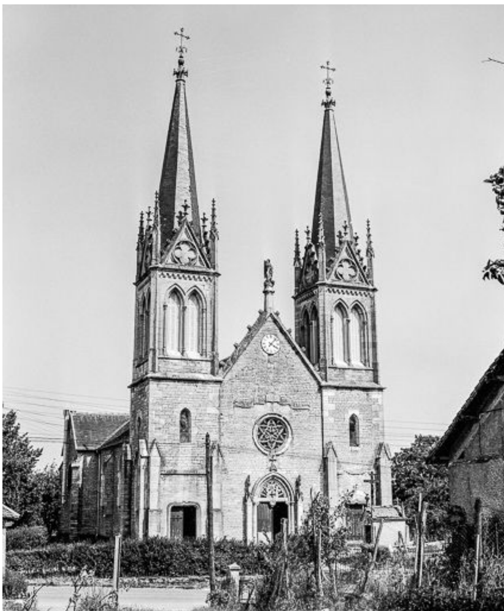
Extérieur : façade antérieure.
