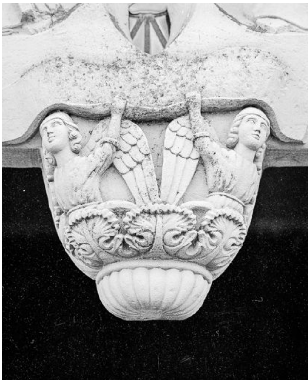
Extérieur : portail, façade antérieure, détail.
