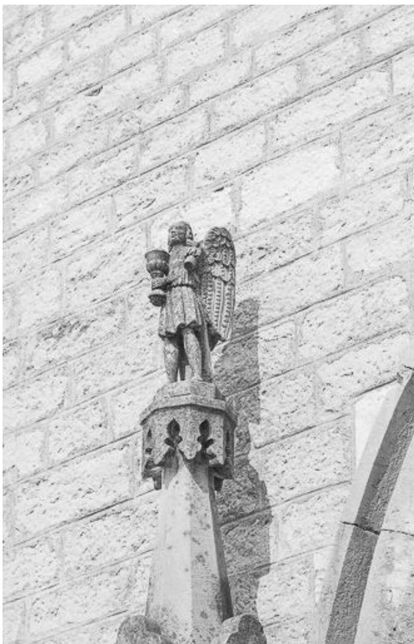
Extérieur : portail, façade antérieure, détail.
