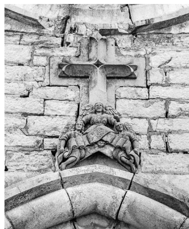
Extérieur : portail, façade antérieure, détail.
