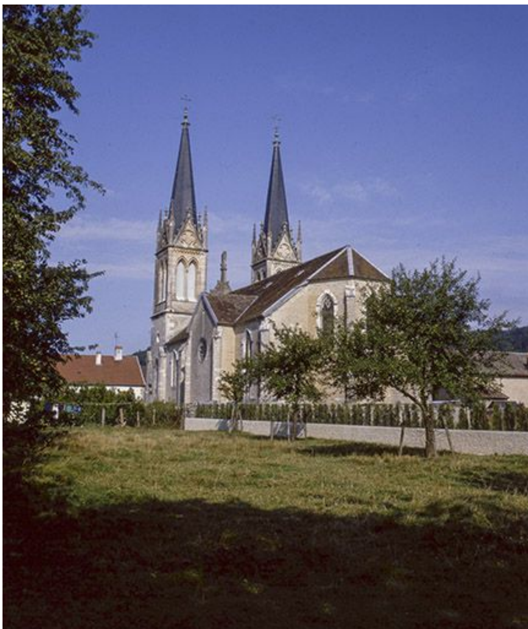
Extérieur : façades postérieure et latérale droite.
