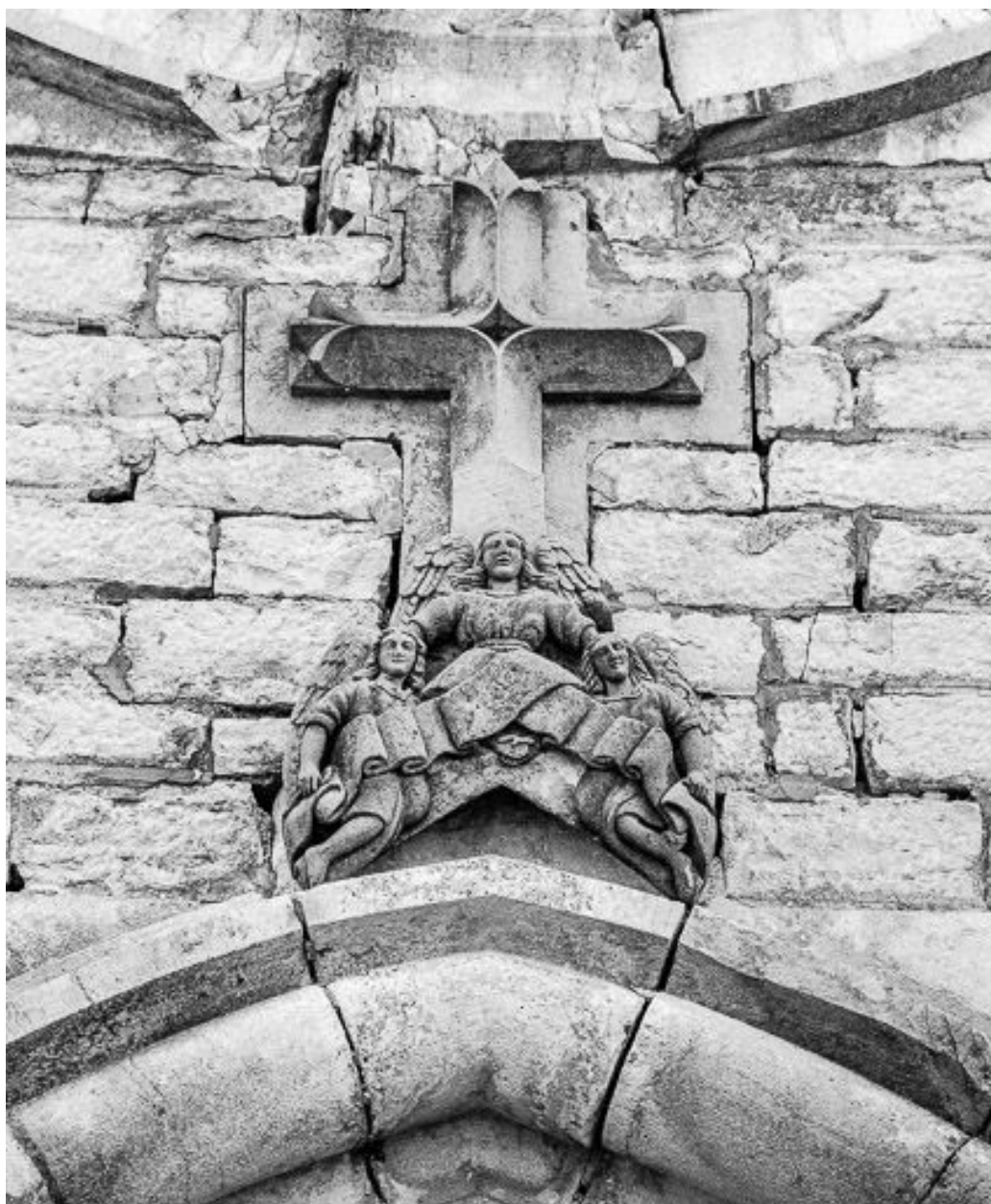
Extérieur : portail, façade antérieure, détail.
