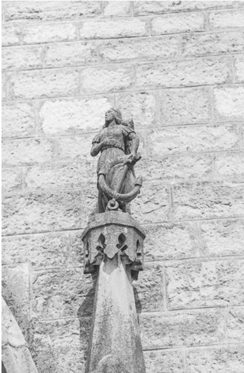
Extérieur : portail, façade antérieure, détail.
