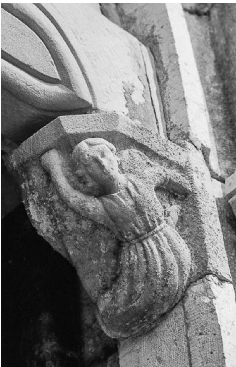
Extérieur : portail, façade antérieure, détail.
