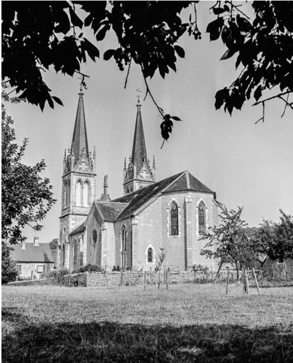
Extérieur : façades postérieure et latérale droite.
