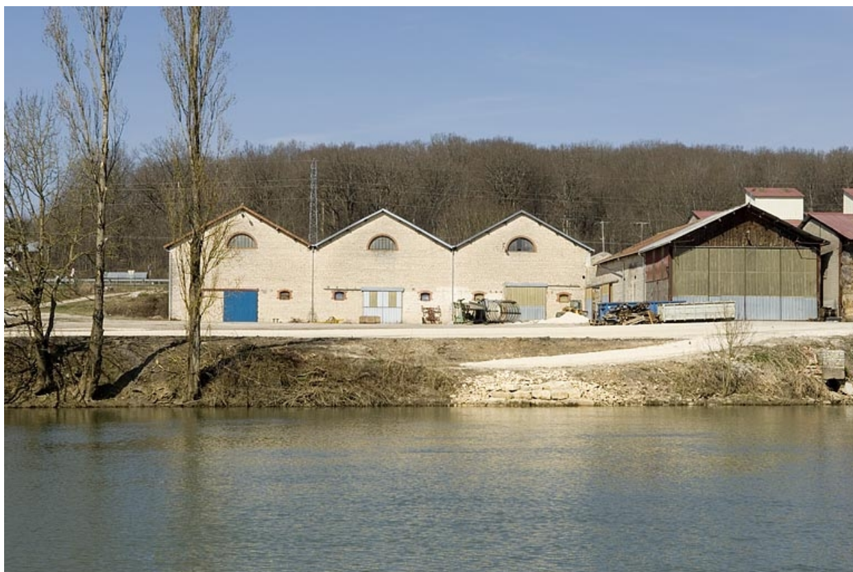
Atelier de fabrication depuis le sud-est.
