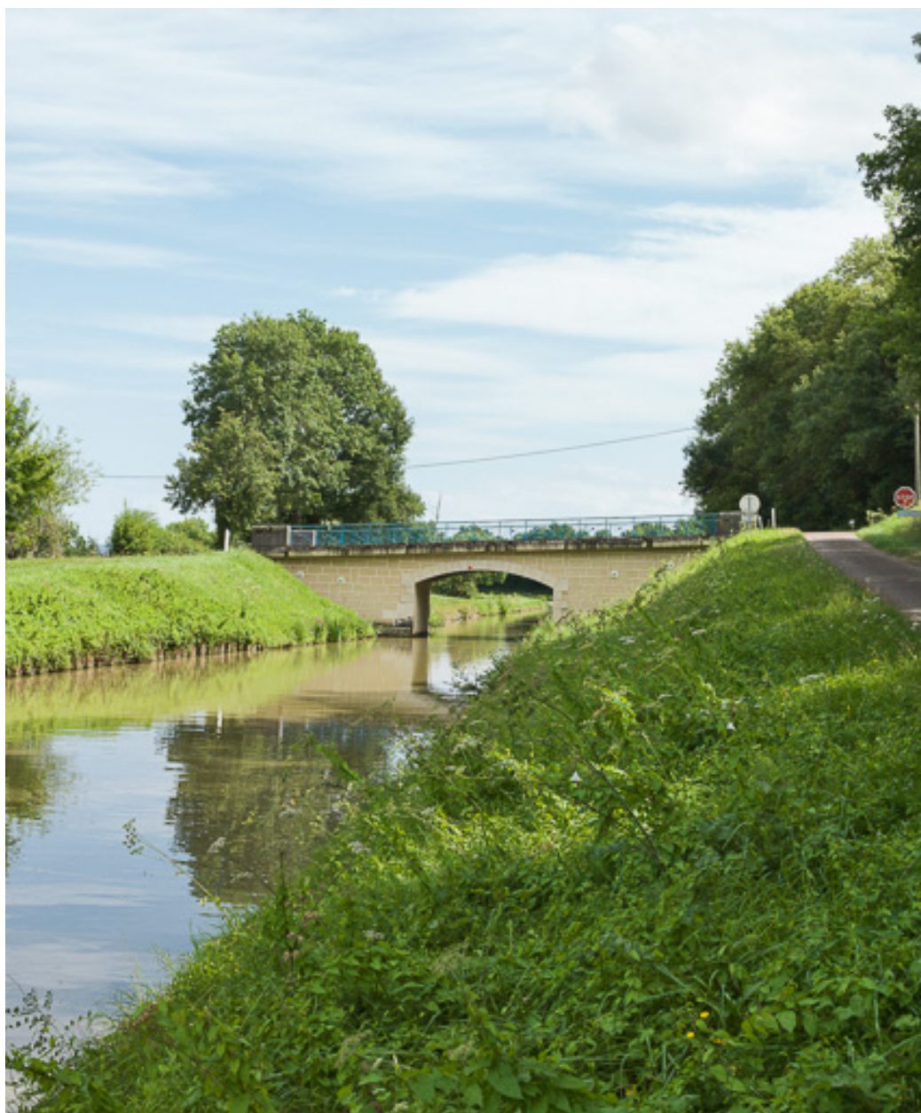
Vue d'ensemble du pont et du site.
