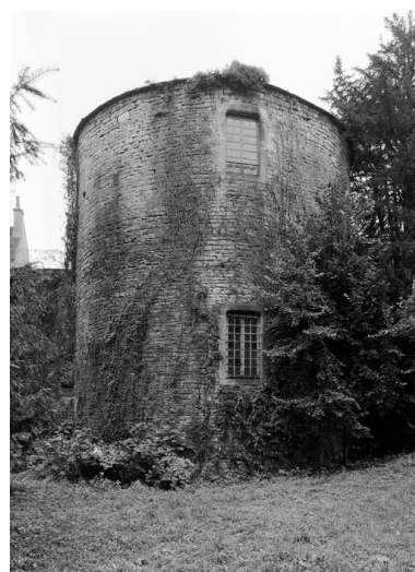
Tour Renard depuis le fossé (en 1988). Phot. Michel Rosso IVR26_19882103225V
