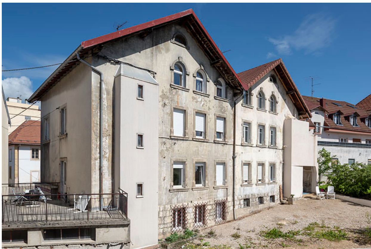
Façades postérieures, de trois quarts gauche.
