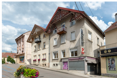
Façades antérieures, de trois quarts droite. Phot. Sonia Dourlot IVR43_20182501243NUC4A
