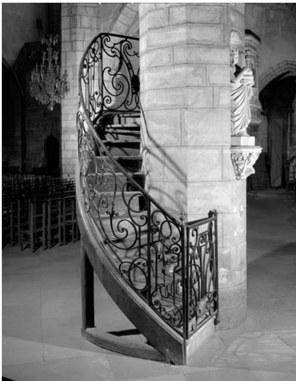
Vue d'ensemble de l'escalier en ferronnerie.
