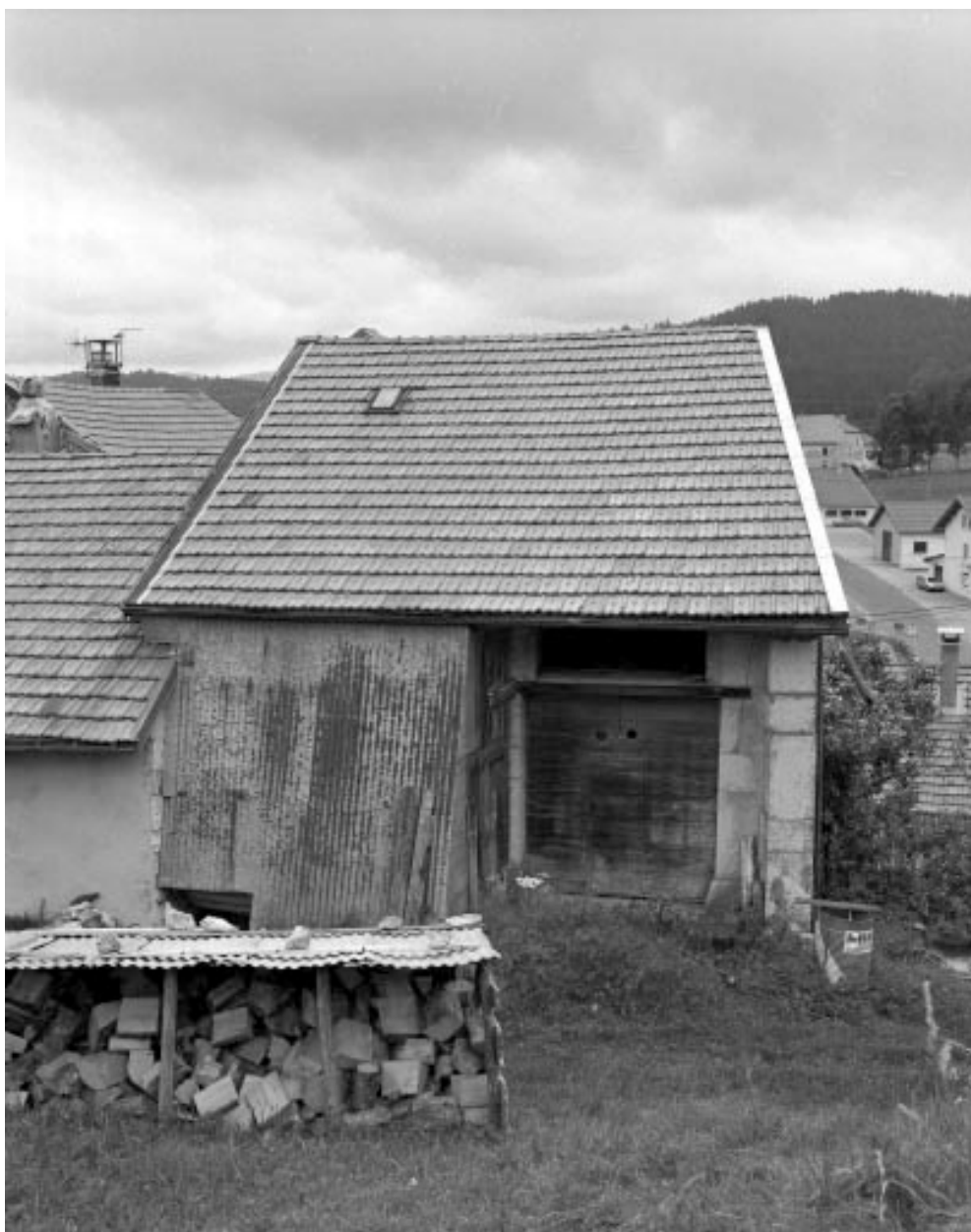
La rue Derrière, accès à une grange.
