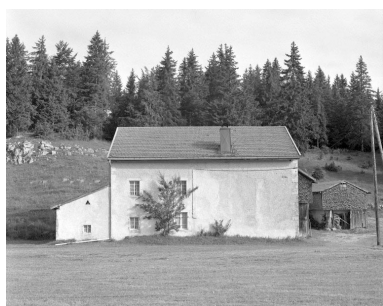
Ferme située au lieu-dit Les Platières. Phot. Jérôme Mongreville IVR43_19943900746X
