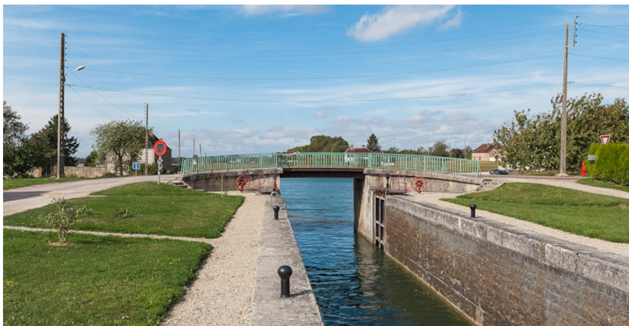
Vue d'ensemble du pont.
