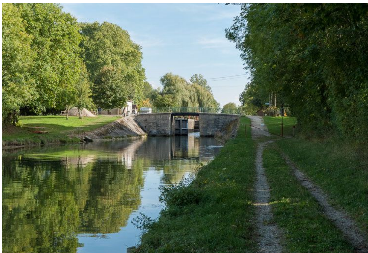
Le pont sur écluse vu d'aval.
