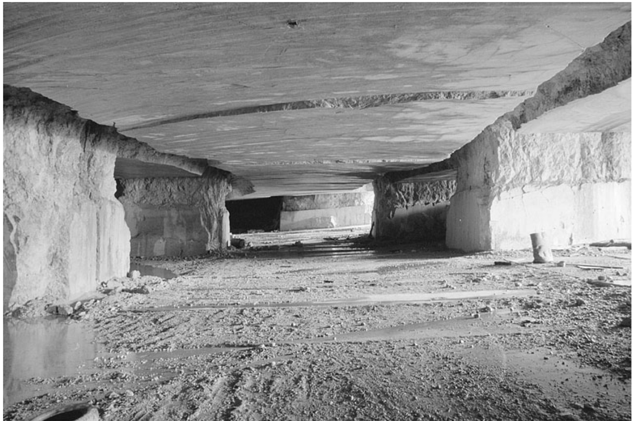
Carrière souterraine de Chassal : galerie latérale.
