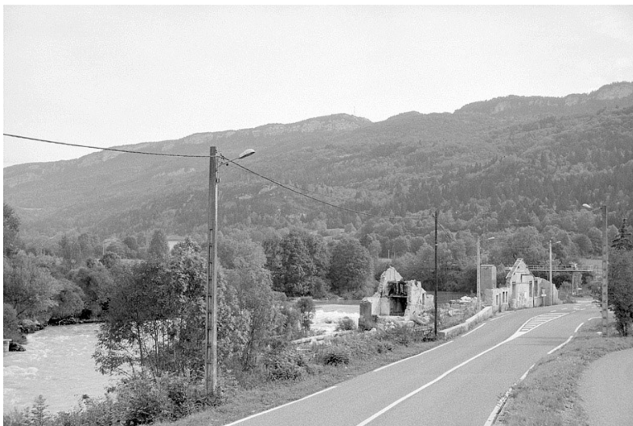
Usine de Molinges : vestiges.
