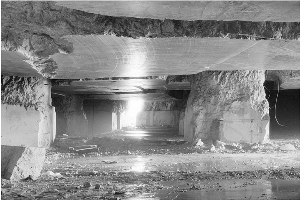
Carrière souterraine de Chassal : galerie latérale.
