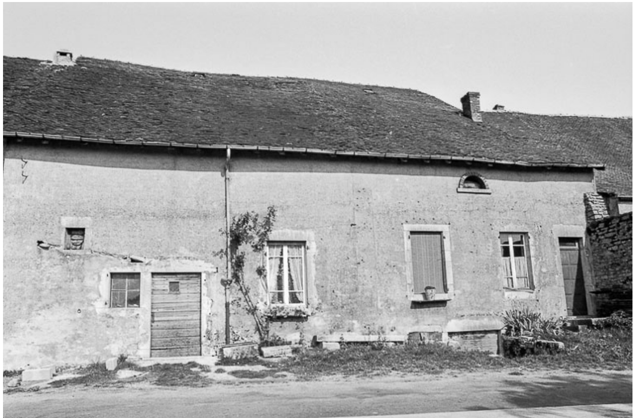
Ferme cadastrée D2 291 : façade postérieure.
