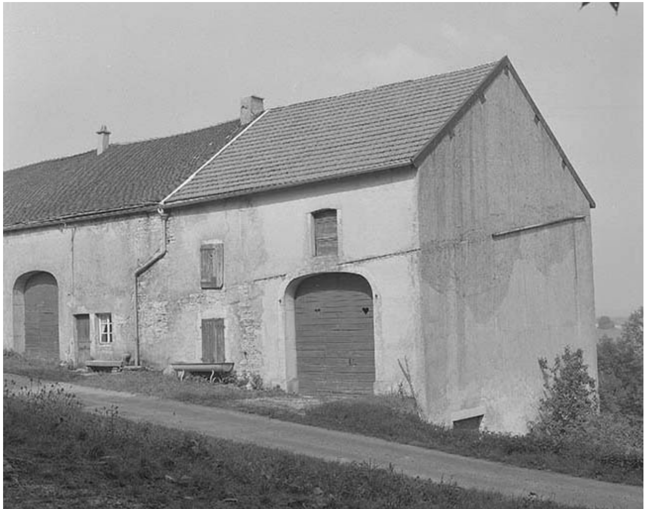
Ferme située chemin de la Gare.
