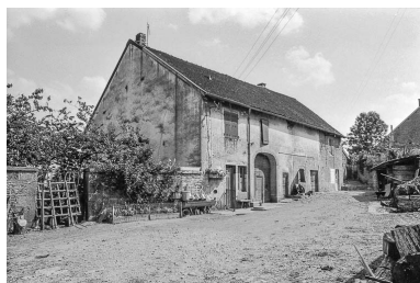
Ferme cadastrée D2 262 et 266 : façade antérieure. Phot. Bernard Pontefract IVR43_19763900343Z
