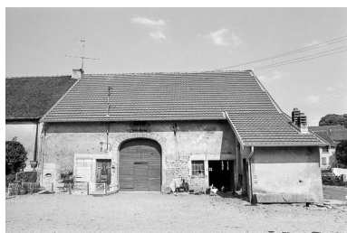
Ferme cadastrée D2 214 : façade antérieure. Phot. Bernard Pontefract IVR43_19763900347Z
