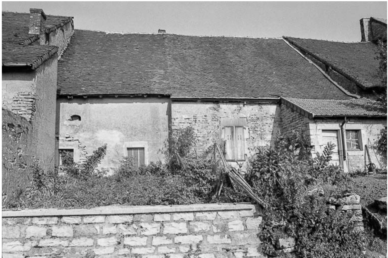
Fermes cadastrées D2 293 et 294 : façades postérieures.
