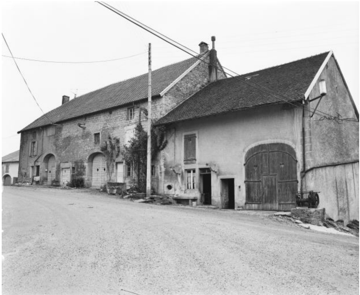
Fermes situées rue de l'Eglise
