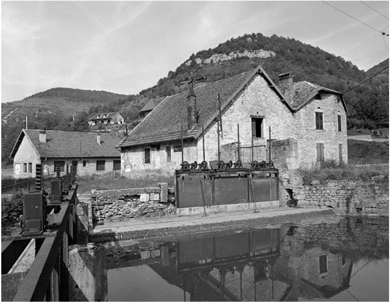
Vue d'ensemble depuis le barrage en 1980.
