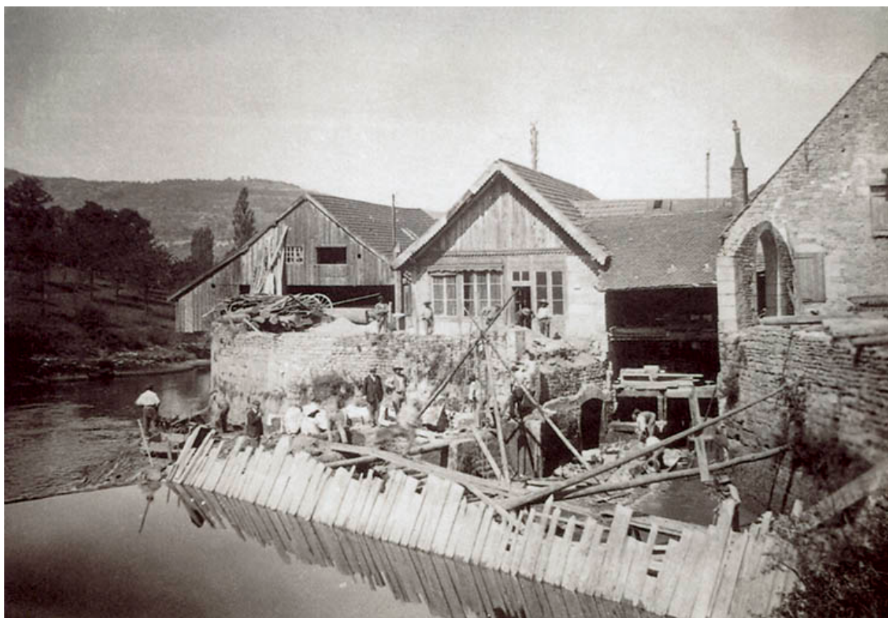
Travaux d'aménagement hydraulique, s.d. [fin 19e siècle].
