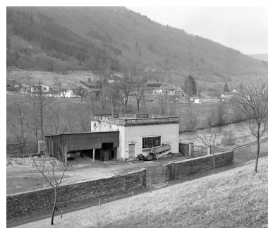
La centrale hydroélectrique en 1982, vue depuis le sud-est. Phot. Yves Sancey IVR43_19822500319X
