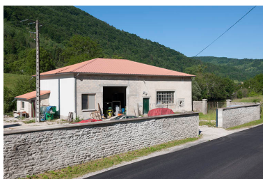
La centrale hydroélectrique. Phot. Jérôme Mongreville IVR43_20152501302NUC4A
