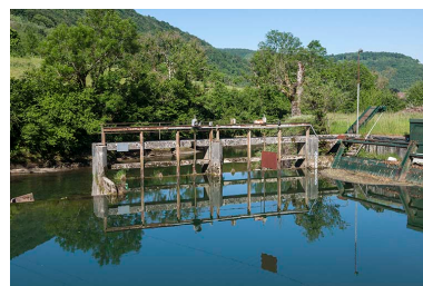
Vannage du barrage. Phot. Jérôme Mongreville IVR43_20152501305NUC4A
