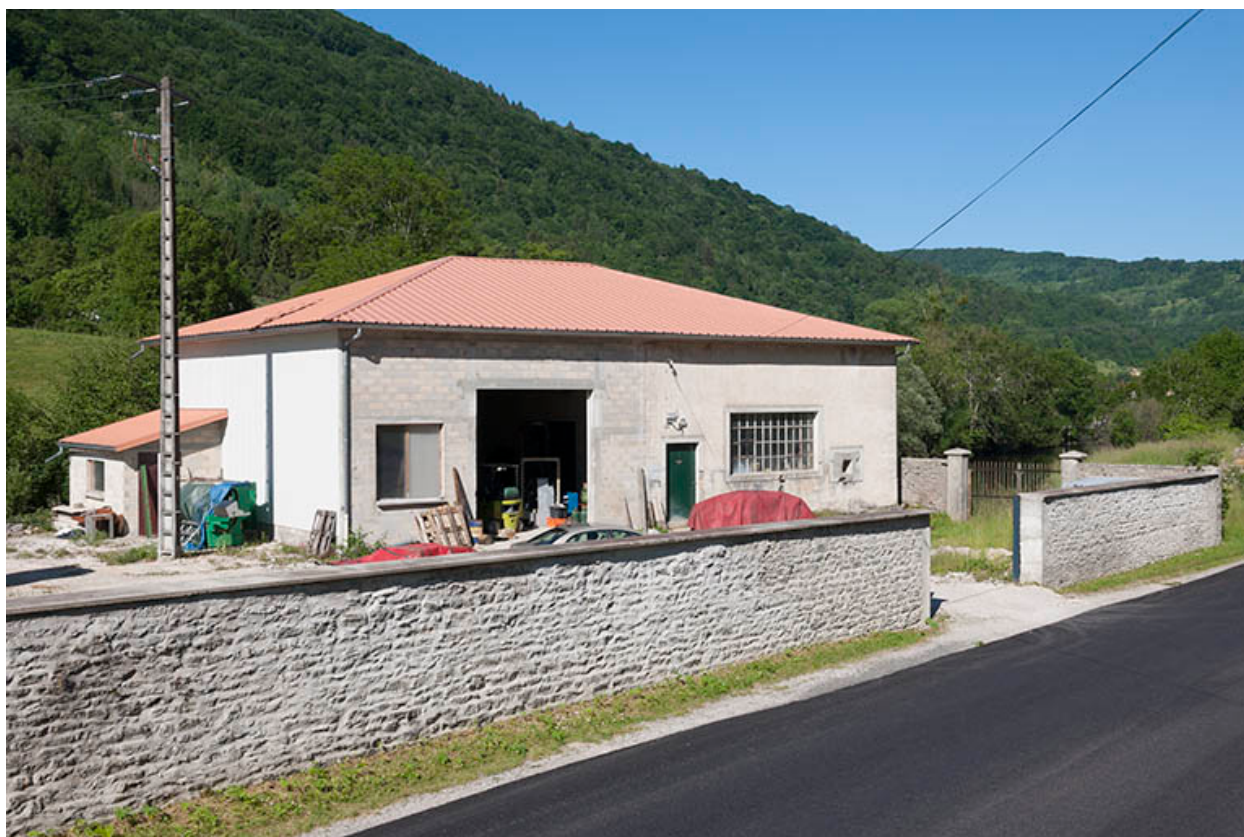
La centrale hydroélectrique.
