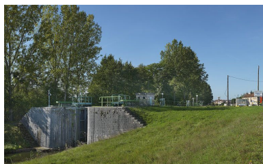
Le site d'écluse 06 vu d'aval. Phot. Thierry Kuntz IVR26_20127100376NUC4A
