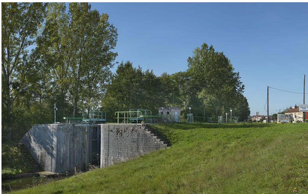
Le site d'écluse 06 vu d'aval.
