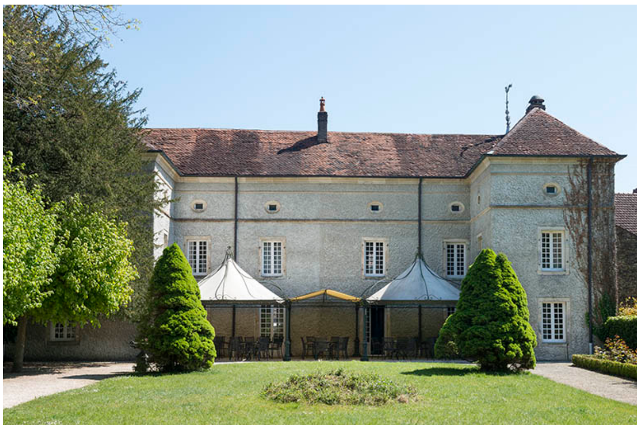
La façade postérieure.
