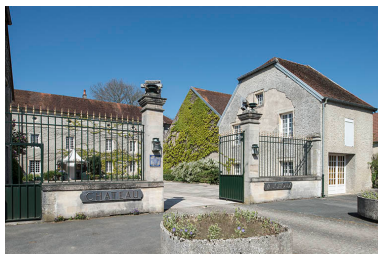
Vue de trois-quarts avec la maison du gardien en arrière plan. Phot. Jérôme Mongreville IVR43_20177000396NUC4A
