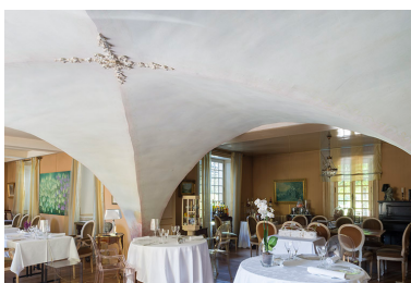
Détail au niveau de la croisée. Phot. Jérôme Mongreville IVR43_20177000391NUC4A
