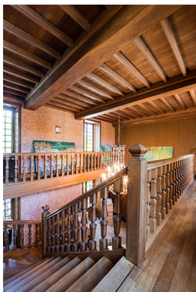
Le plafond à la française, hall d'entrée. Phot. Jérôme Mongreville IVR43_20177000407NUC4A
