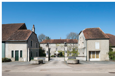
Vue générale. Phot. Jérôme Mongreville IVR43_20177000395NUC4A
