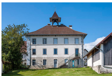
Façade postérieure. Phot. Jérôme Mongreville IVR43_20142501117NUC4A
