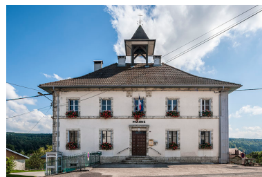
Façade antérieure. Phot. Jérôme Mongreville IVR43_20142501115NUC4A
