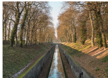
Vue d'ensemble de la tranchée. Phot. Pierre-Marie Barbe-Richaud IVR26_20132101068NUC4AQ
