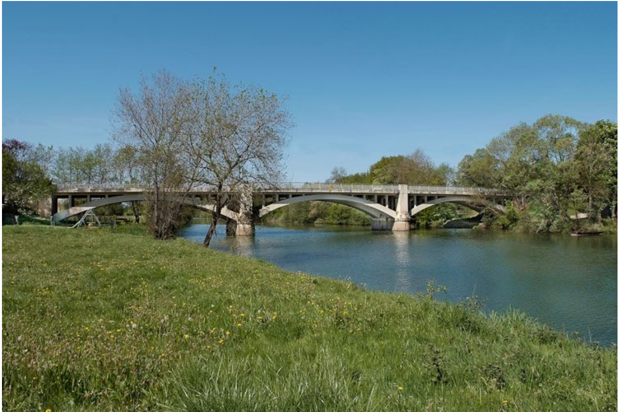
Pont routier sur la D933.
