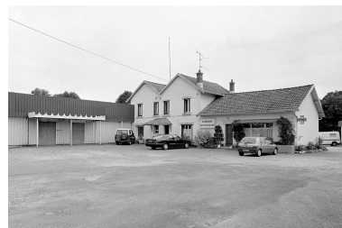
Façade des bureaux (?). Phot. Yves Sancey IVR43_20009000267X
