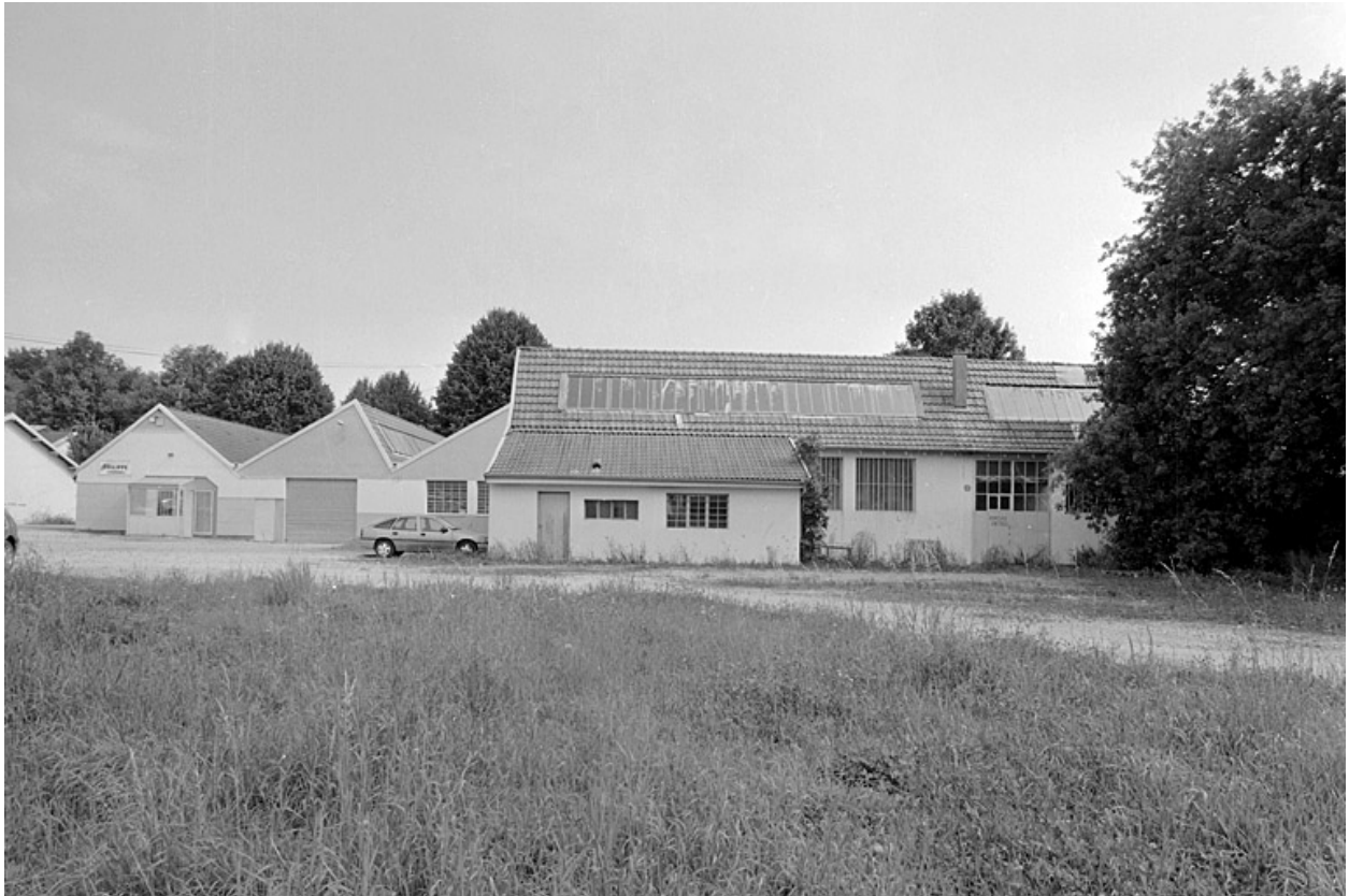
Ateliers de fabrication depuis le sud.
