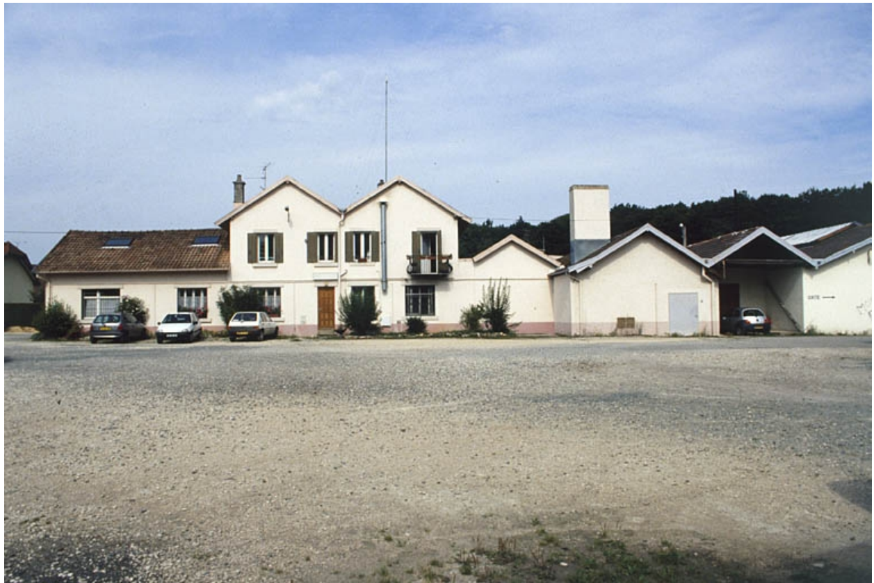
Façade postérieure des bâtiments sur rue.
