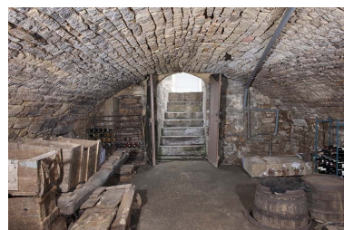
Sous-sol, en direction de l'entrée. Phot. Jérôme Mongreville IVR43_20127000446NUC4A
