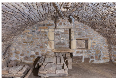
Sous-sol, depuis l'entrée. Phot. Jérôme Mongreville IVR43_20127000445NUC4A
