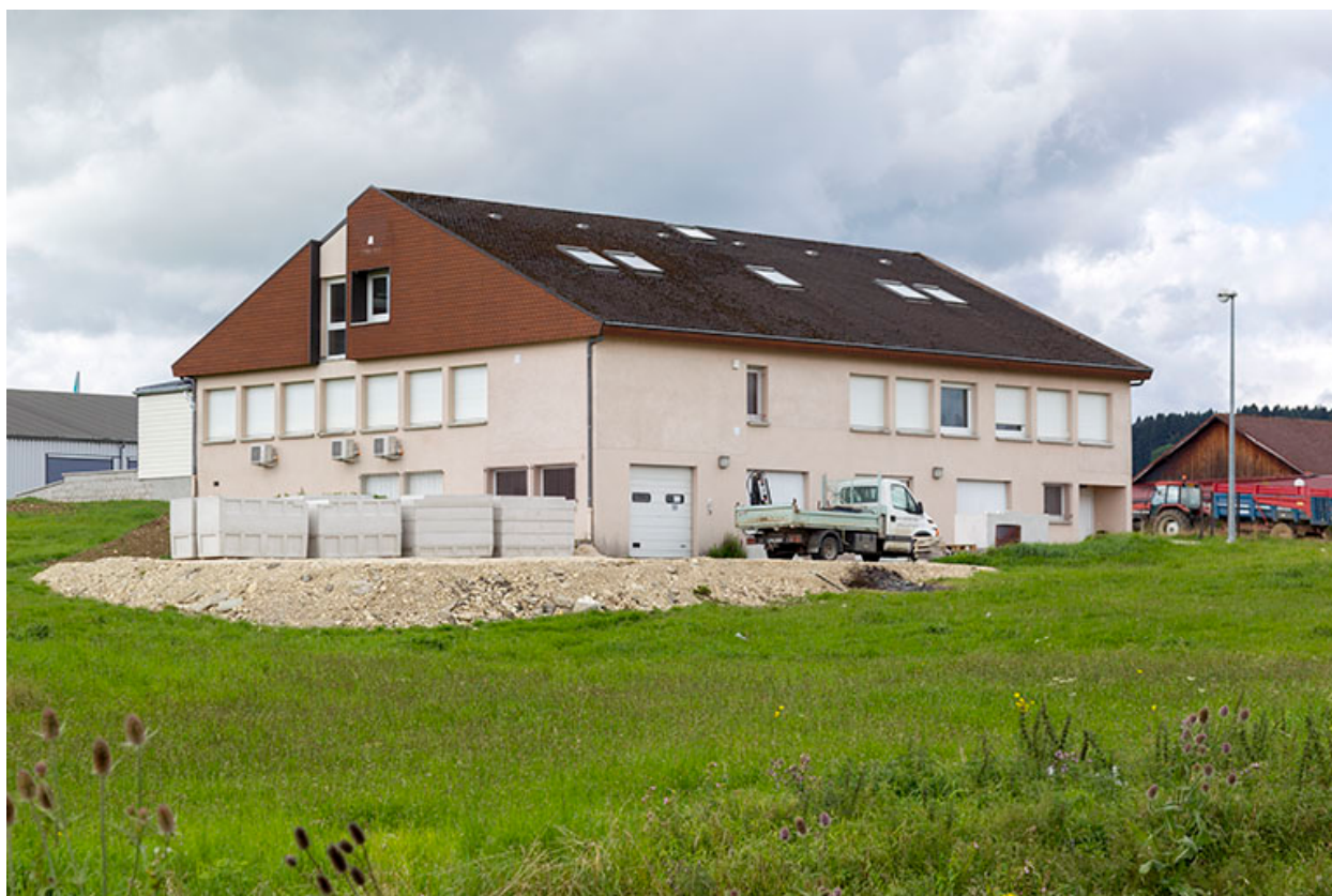
Façades postérieure et latérale droite.
