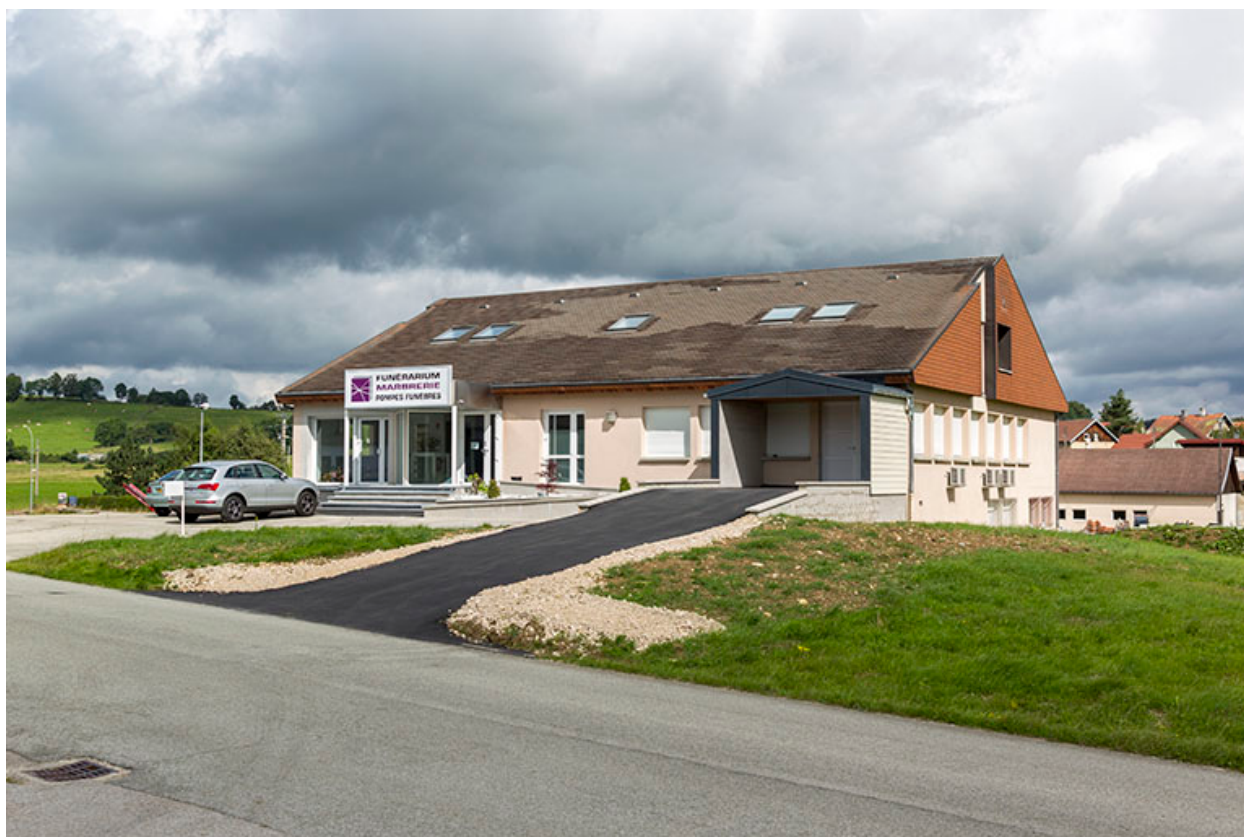
Façades antérieure et latérale droite.
