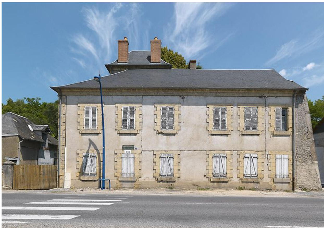
La maison éclusière, vue de face.
