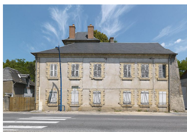
La maison éclusière, vue de face. Phot. Thierry Kuntz IVR26_20135800350NUC4A
