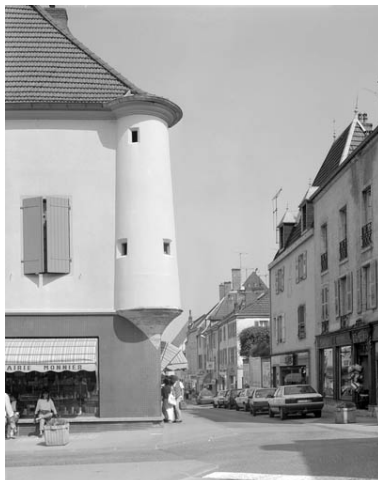
Détail de l'oriel. Phot. Yves Sancey IVR43_19897000353V
