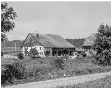
Ferme située au lieudit Friard.
