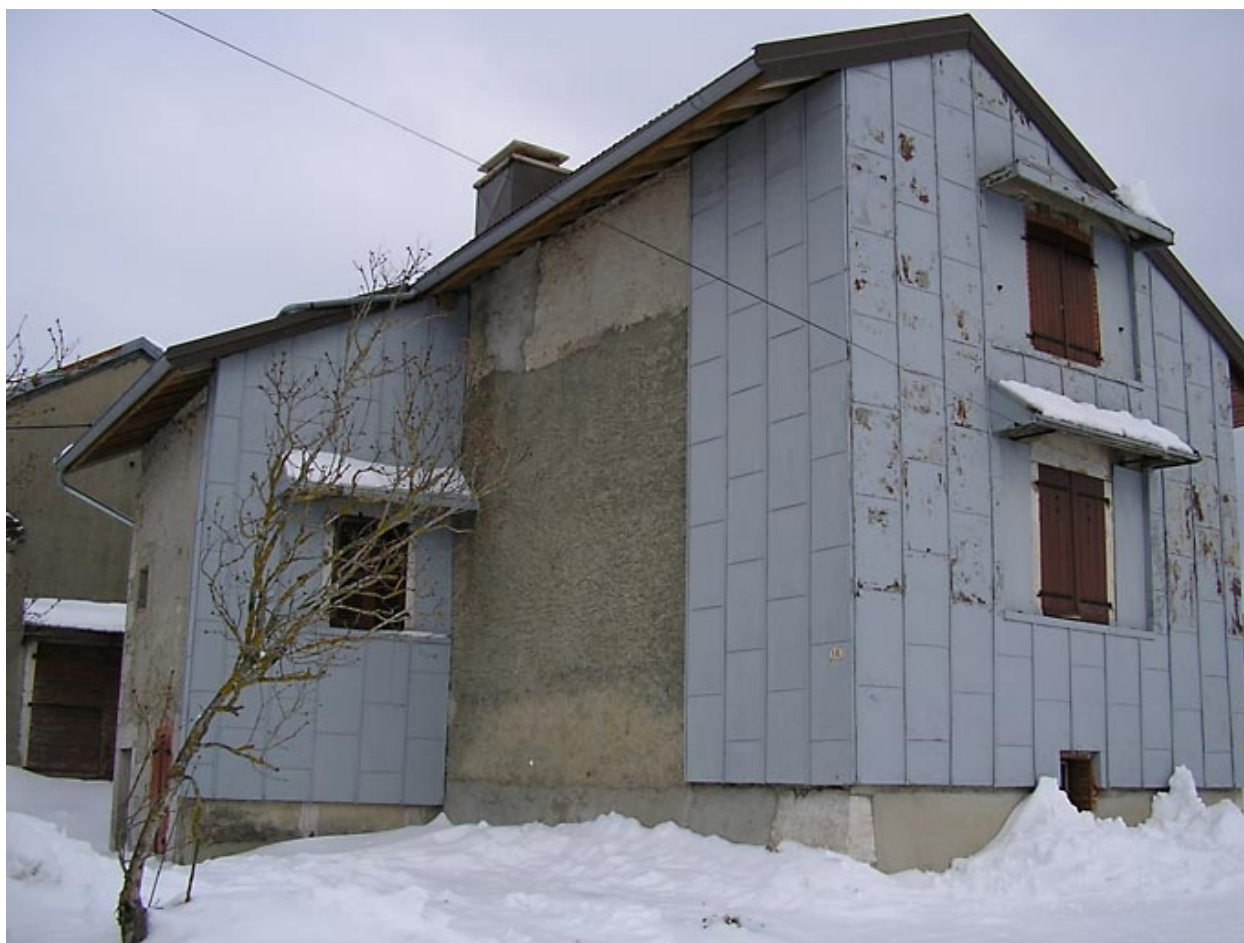
Vue du pignon sud-ouest.
