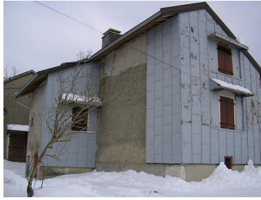
Vue du pignon sud-ouest. Phot. Marie-Pierre Reynet IVR43_20083900219NUC1A
