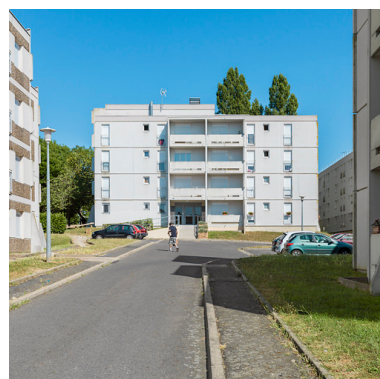
Bâtiment 27, façade antérieure ouest.
