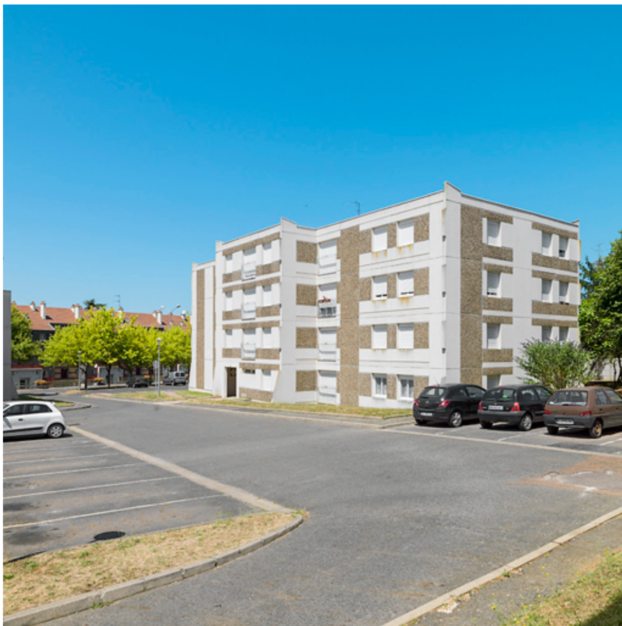
Bâtiment 26, façades antérieure et latérale.
