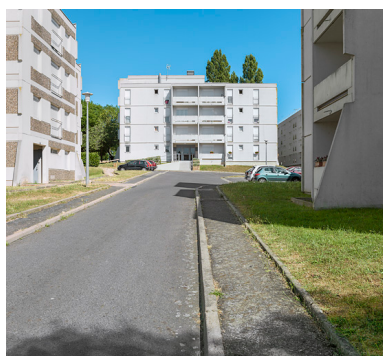
Bâtiment 27, façade antérieure ouest.
