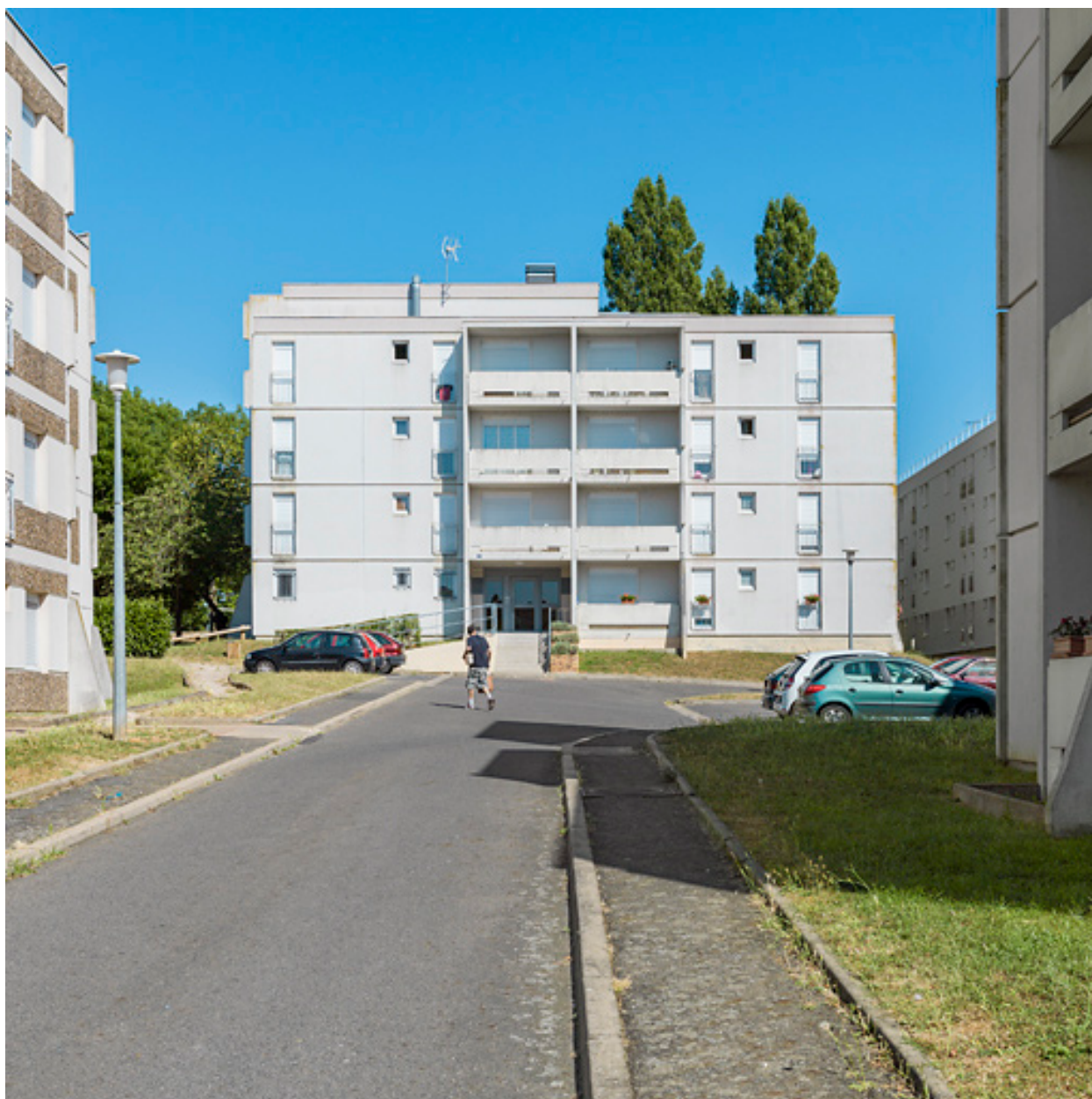
Bâtiment 27, façade antérieure ouest.
