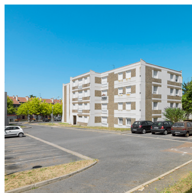
Bâtiment 26, façades antérieure et latérale.
