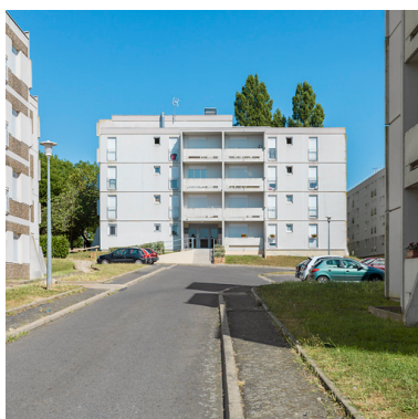
Bâtiment 27, façade antérieure ouest.
