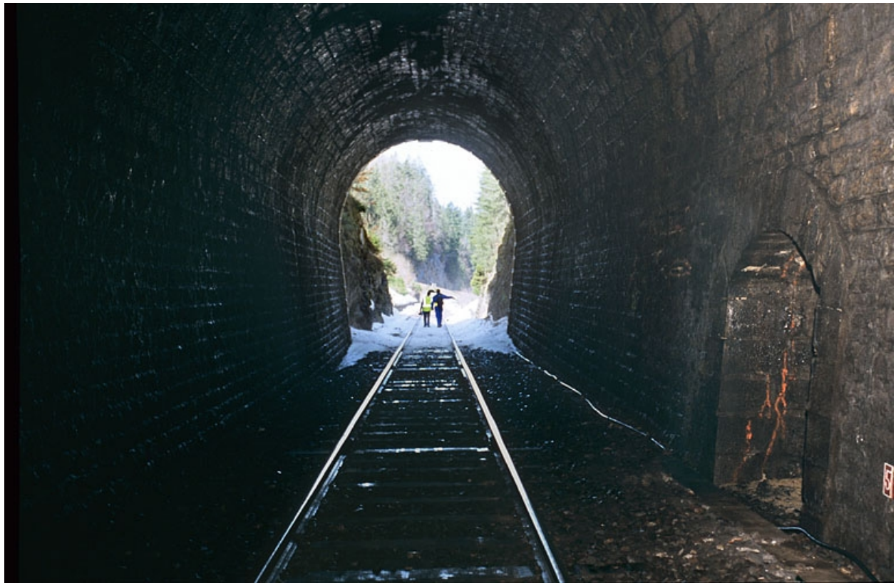
Intérieur (côté Andelot-en-Montagne) : tête et refuge.
