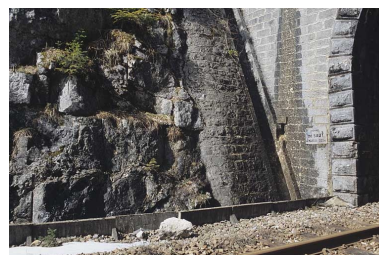
Tête côté La Cluse : descente d'eau, chantepleure et caniveau (détail). Phot. Yves Sancey IVR43_20053900240ZA
