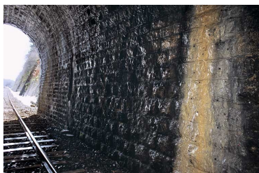
Intérieur (côté La Cluse) : appareil à bossages du mur et voile de calcite. Phot. Yves Sancey IVR43_20053900243ZA
