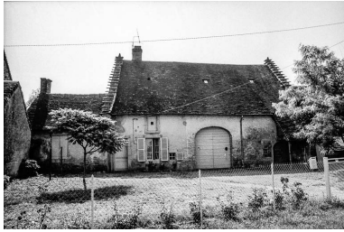
Façade antérieure en 1975. Phot. Bernard Pontefract IVR43_19753900396Z
