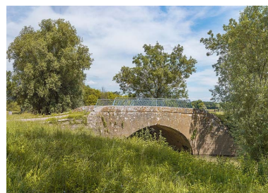
Vue d'ensemble du pont.
