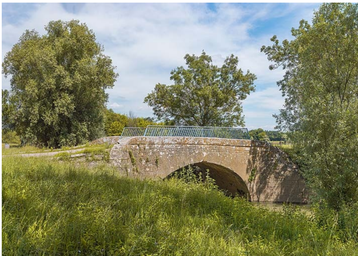
Vue d'ensemble du pont.
