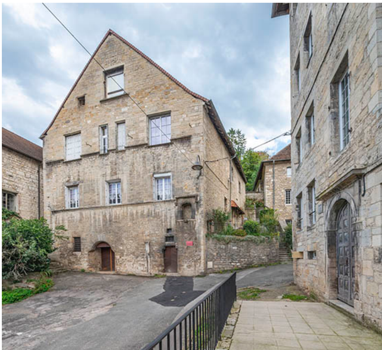
Façade ouest vue de trois quarts droite.
