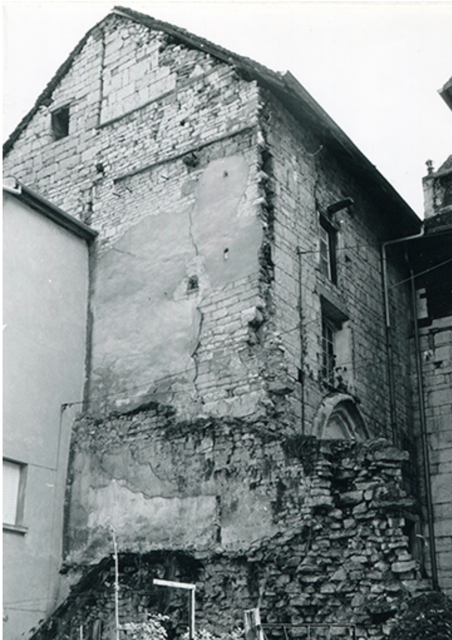
Mur-pignon ouest de la chapelle, 1990.
