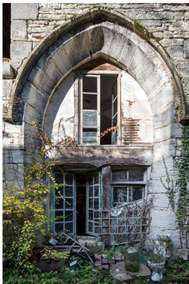
Fenêtre à arc brisé du chevet. Phot. Nicolas Waltefaugle IVR43_20253900160NUC4A
