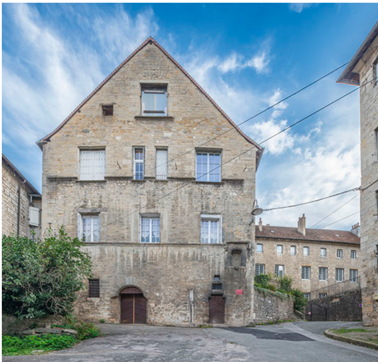
Façade ouest vue de face.
