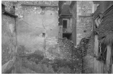
Mur sud de la chapelle, s.d. [vers 1970]. Phot. Jean-Marie Maronnier IVR43_20243900920NUC2A
