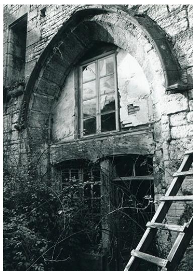
Chapelle. Baie couverte d'un arc en cintre brisé, 1990. Phot. Patrick Blandin IVR43_20253900105NUC4A
