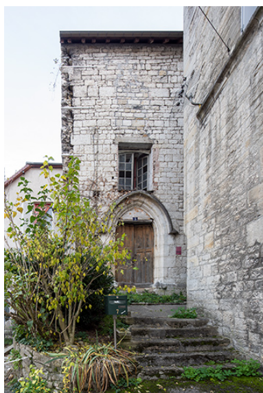
Partie ouest et porte de la chapelle. Phot. Nicolas Waltefaugle
