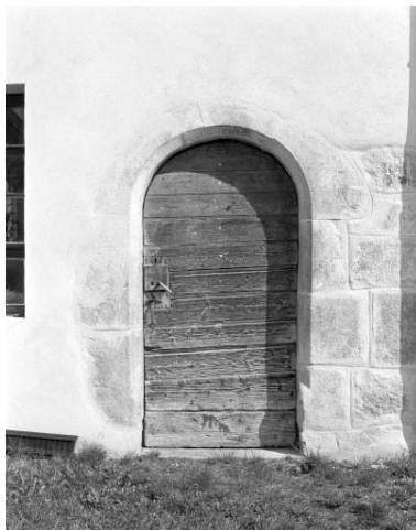
La porte d'entrée. Phot. Jérôme Mongreville IVR43_19943901100X
