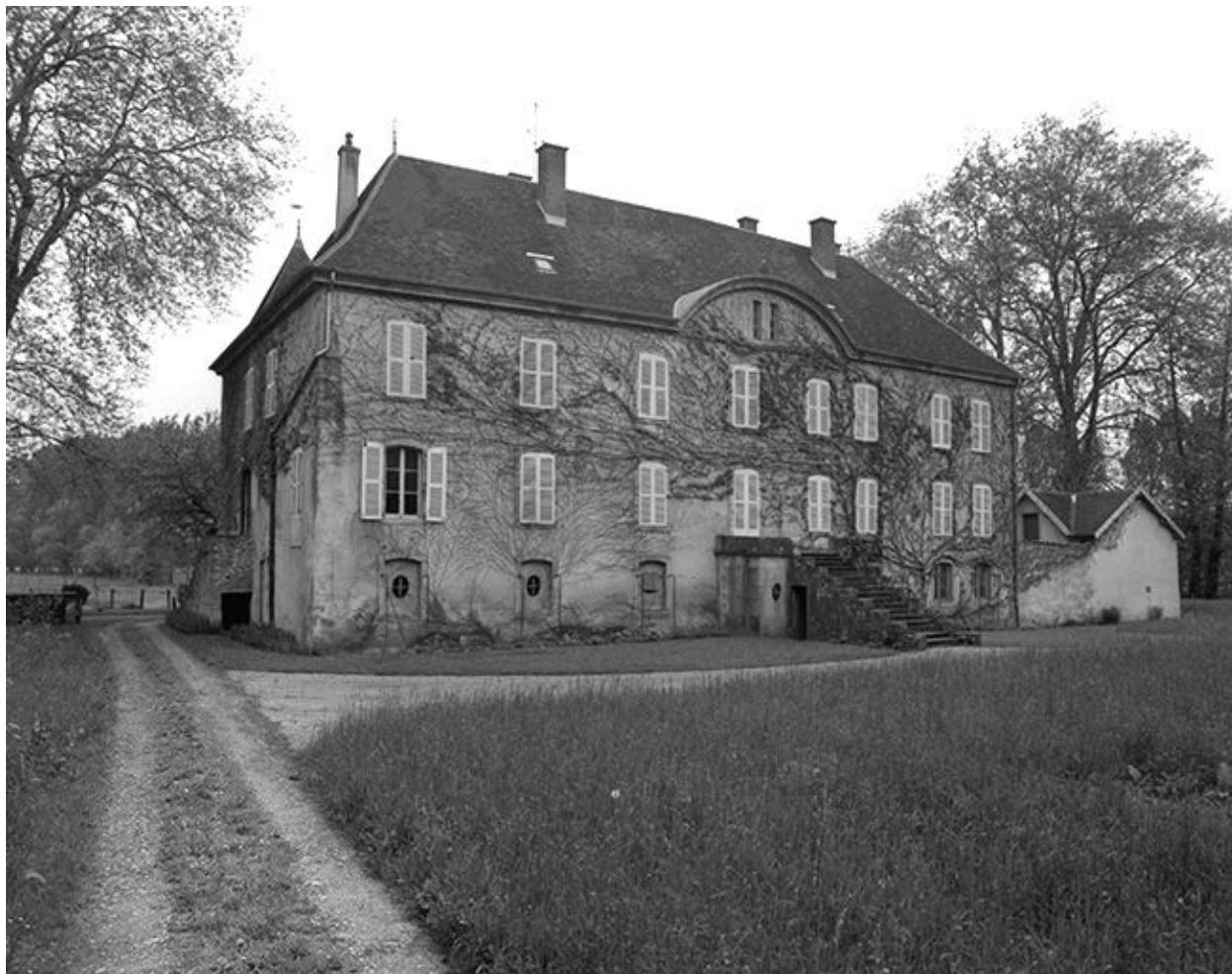
Façade principale, vue de trois quarts.
