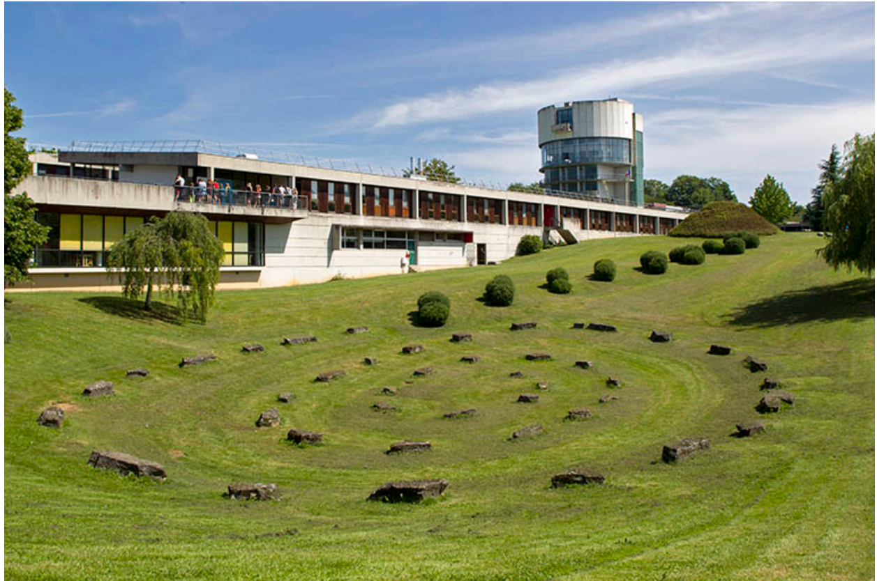
Vue sur l'installation paysagère et les façades antérieures depuis le sud-ouest.
