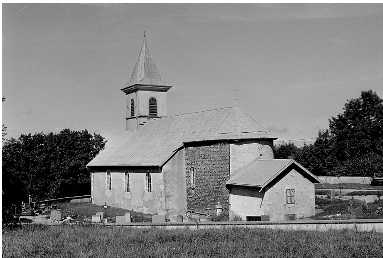
Extérieur : abside et face sud.
