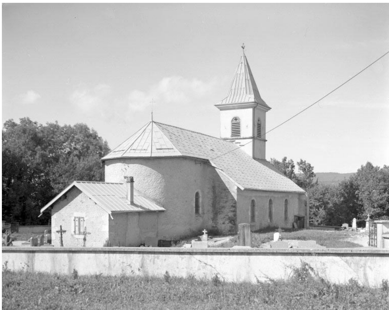
Extérieur : abside et face nord.
