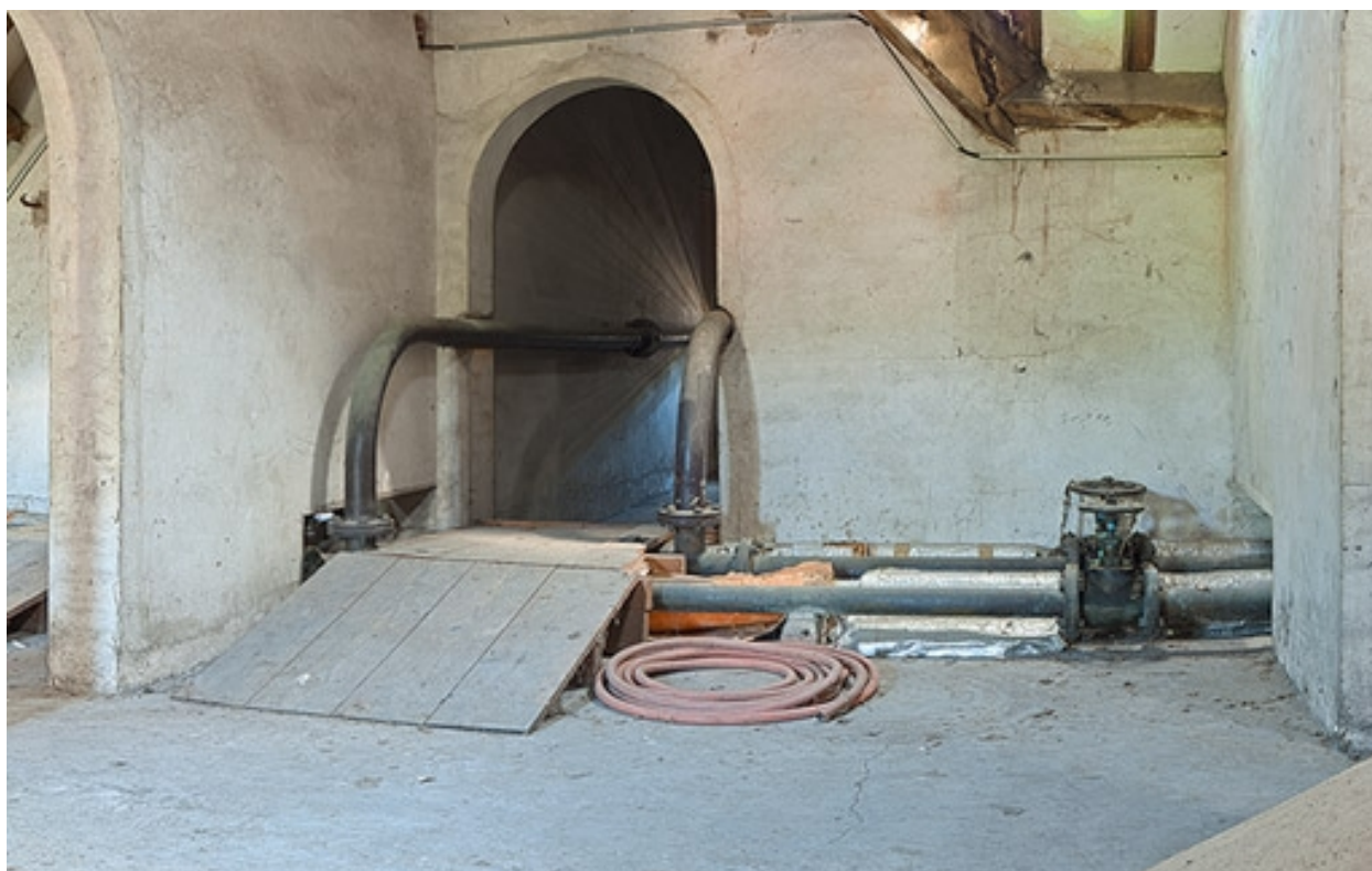
Comble : porte menant à l'aqueduc.
