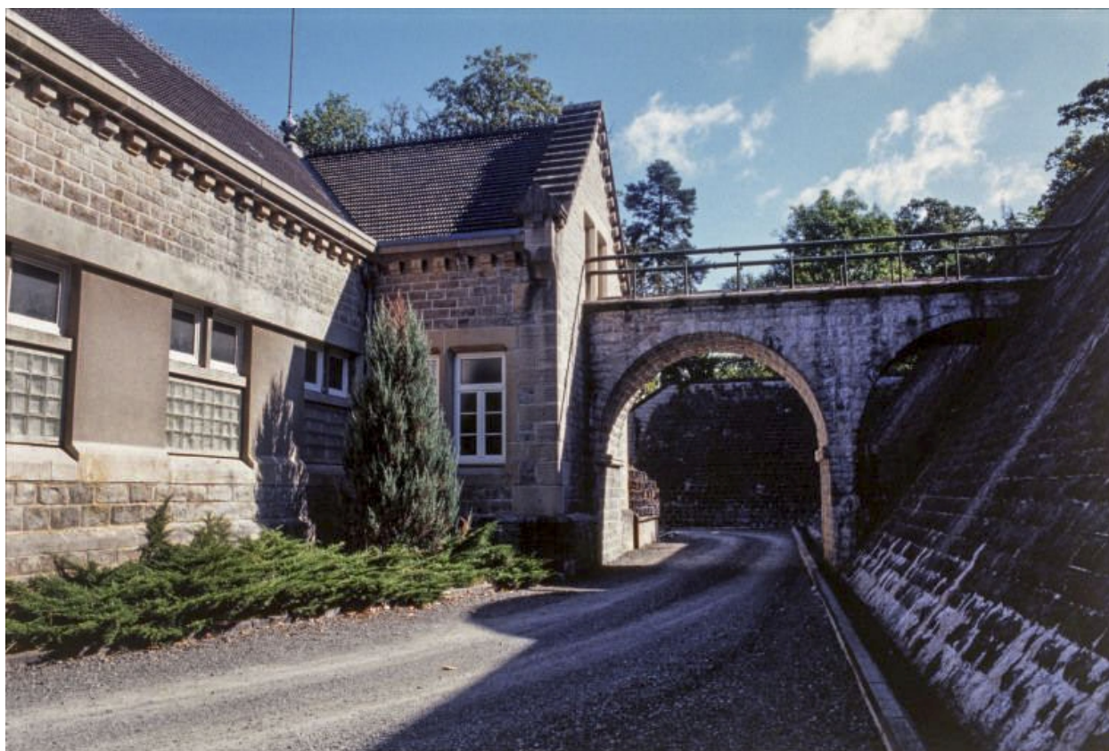
Élévation postérieure et pont-aqueduc.
