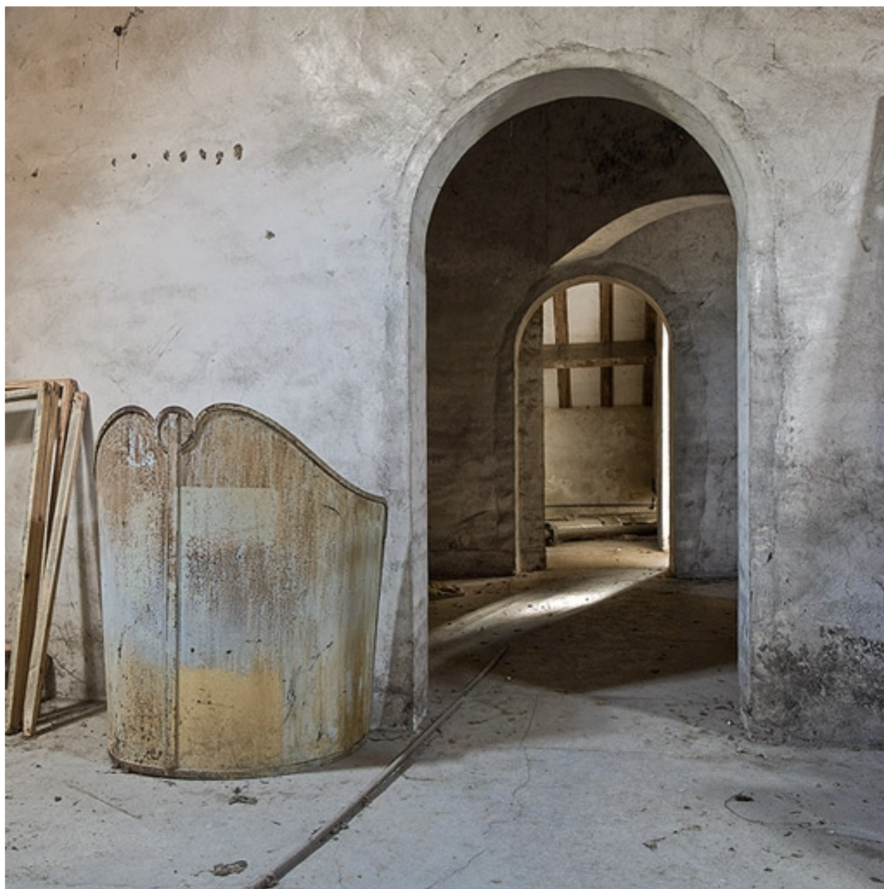
Comble : partie droite du corps central.
