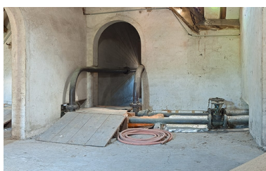
Comble : porte menant à l'aqueduc. Phot. Pierre-Marie Barbe-Richaud IVR26_20107101018NUC4AQ
