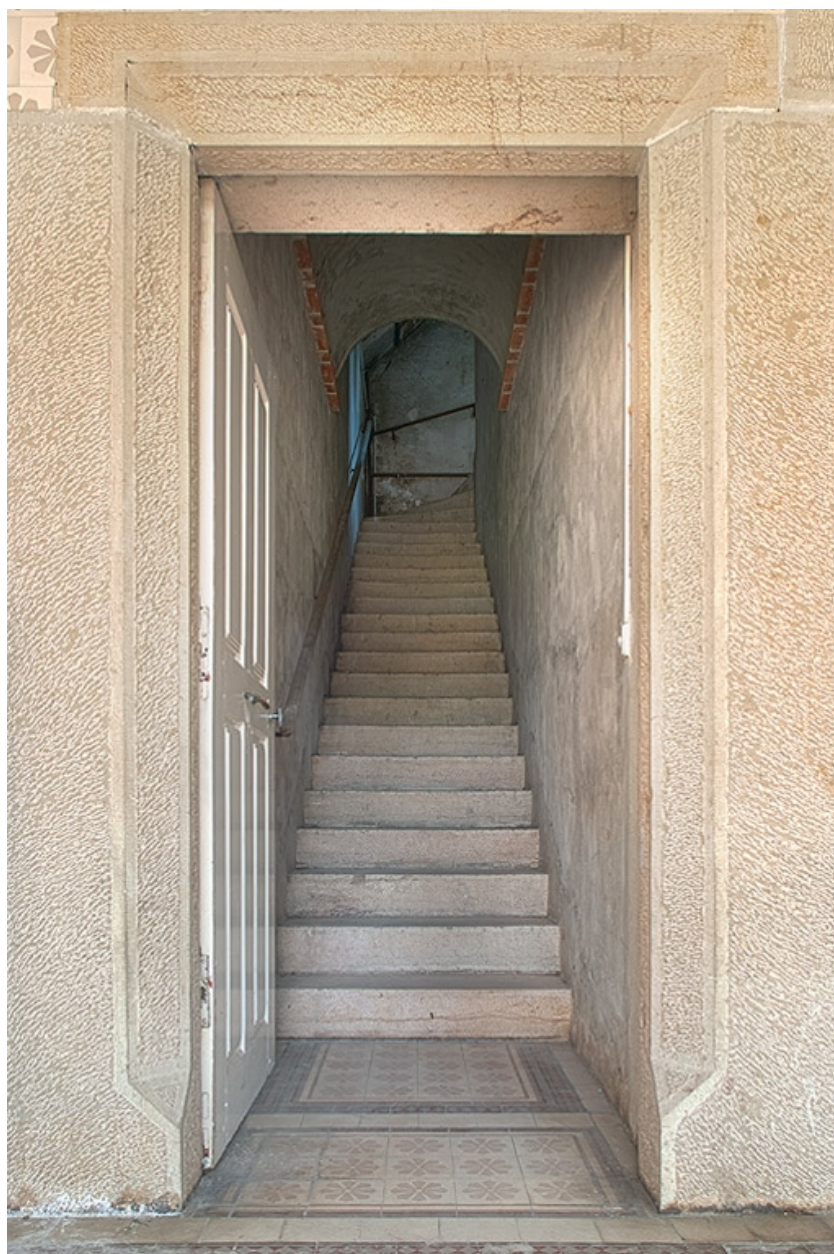
Corps central, escalier du comble.
