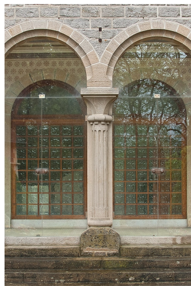
Détail des arcades. Phot. Pierre-Marie Barbe-Richaud IVR26_20107100979NUC2A
