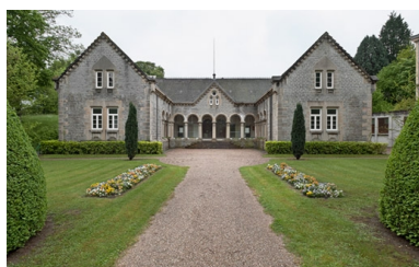
Vue d'ensemble, de face. Phot. Pierre-Marie Barbe-Richaud IVR26_20107100977NUC4AQ
