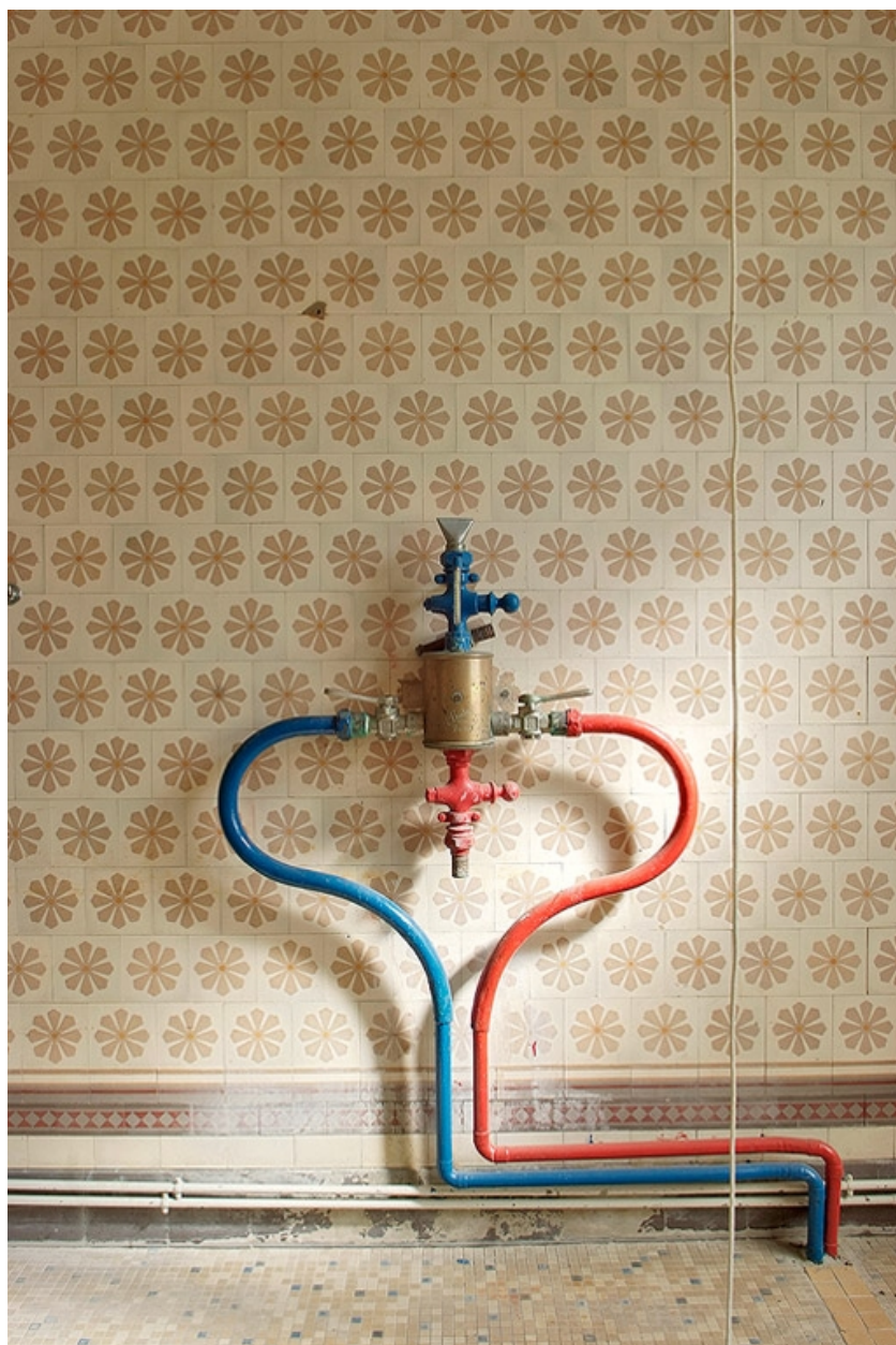
Corps central, salle de bain à droite du couloir du cabinet du médecin, détail du mitigeur.
