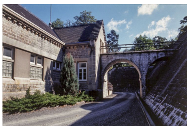
Élévation postérieure et pont-aqueduc. Phot. Jean-Luc Duthu IVR26_20017100724ZA
