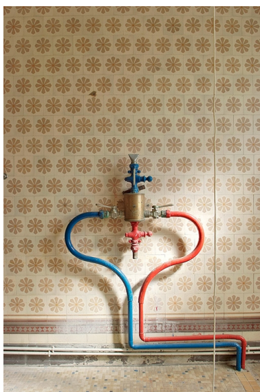
Corps central, salle de bain à droite du couloir du cabinet du médecin, détail du mitigeur. Phot. Pierre-Marie Barbe-Richaud IVR26_20107101004NUC2A
