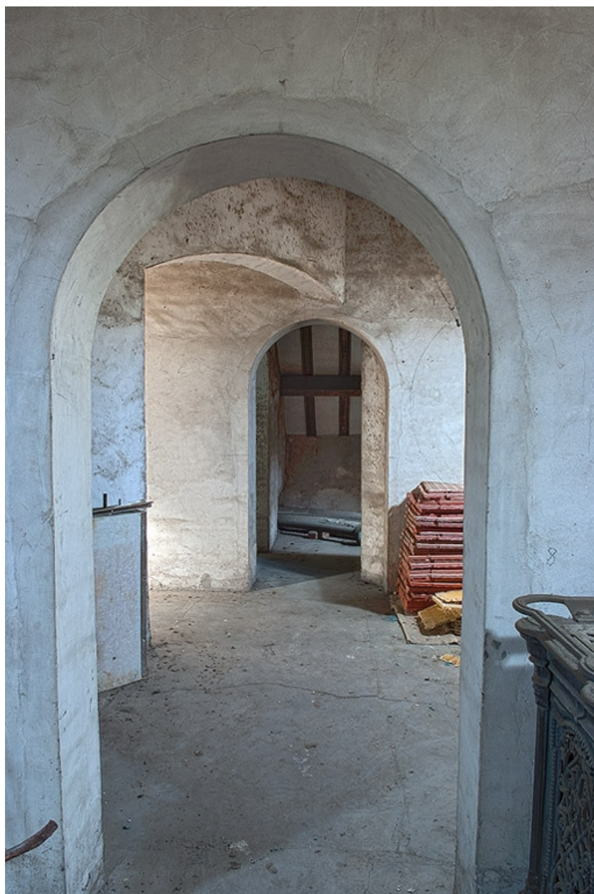
Comble : partie gauche du corps central.
