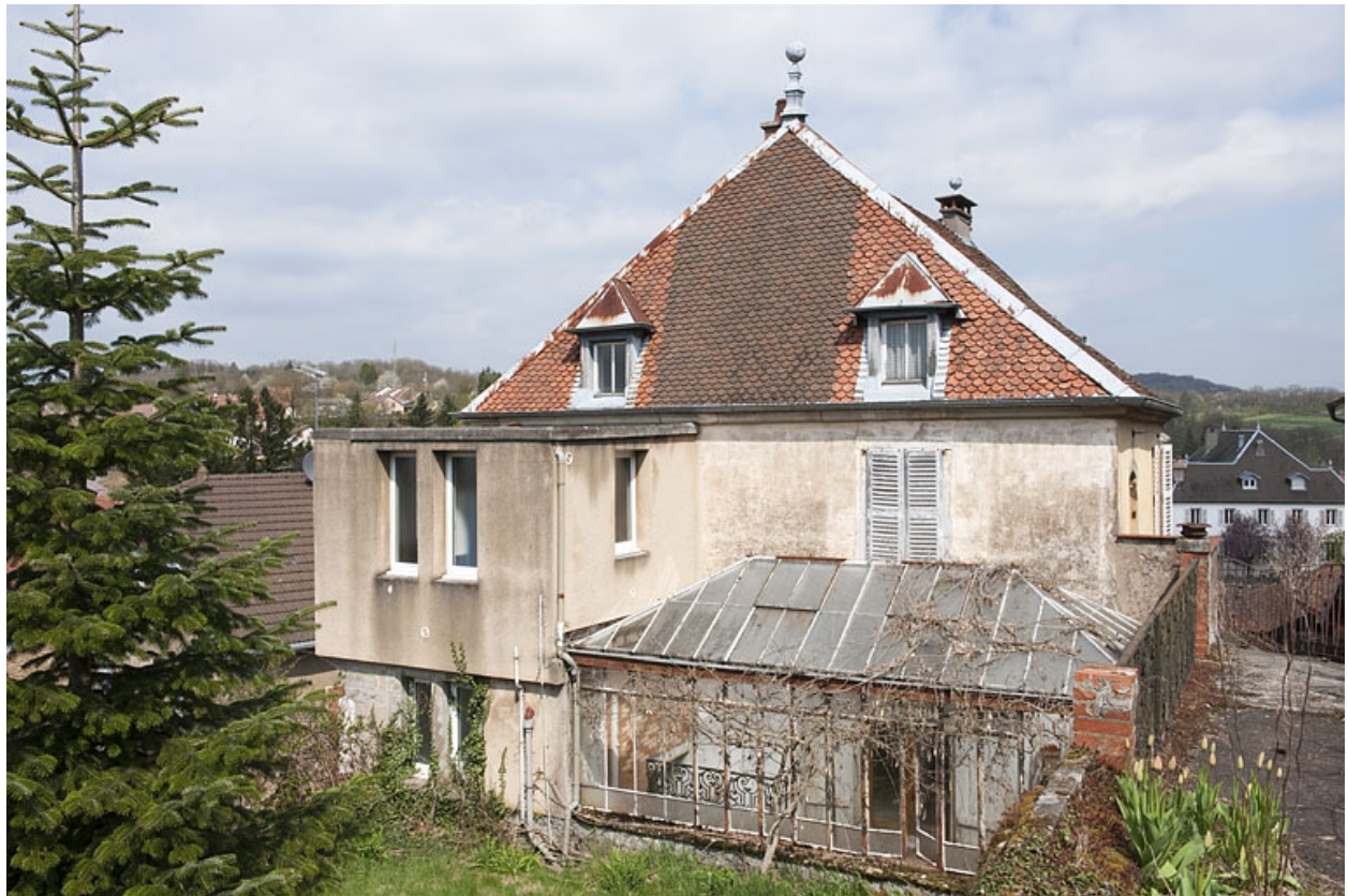
Façade latérale (ouest).
