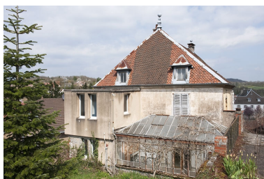
Façade latérale (ouest). Phot. Jérôme Mongreville IVR43_20102501315NUC4A
