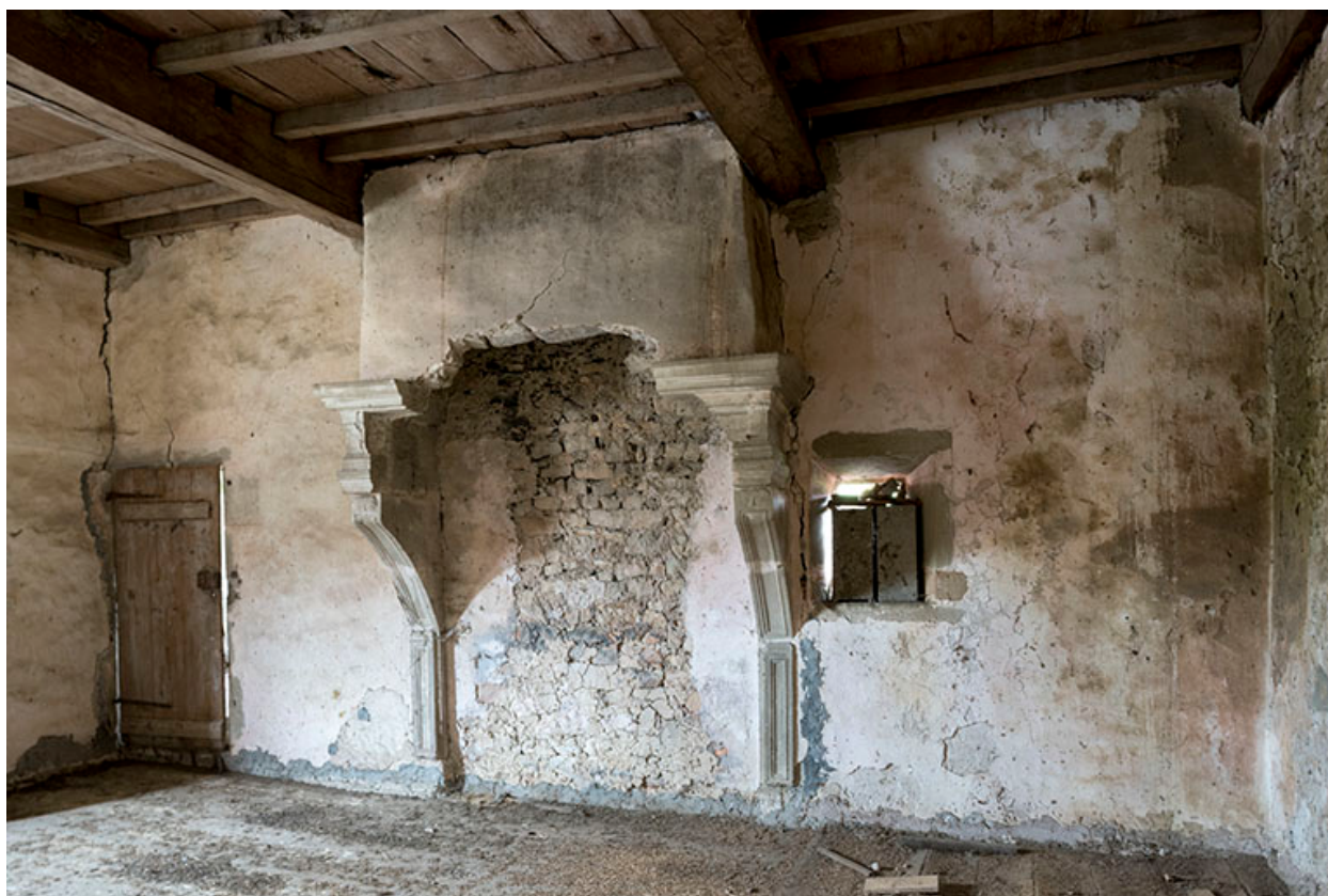
Cheminée adossée, à l'étage de l'ancien logis.
