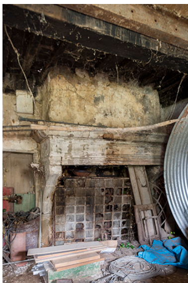
Cheminée adossée, au rez- de-chaussée de l'ancien logis. Phot. Sonia Dourlot IVR43_20167001234NUC4A
