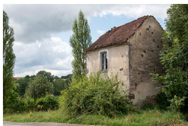
maison 2 rue du moulin
