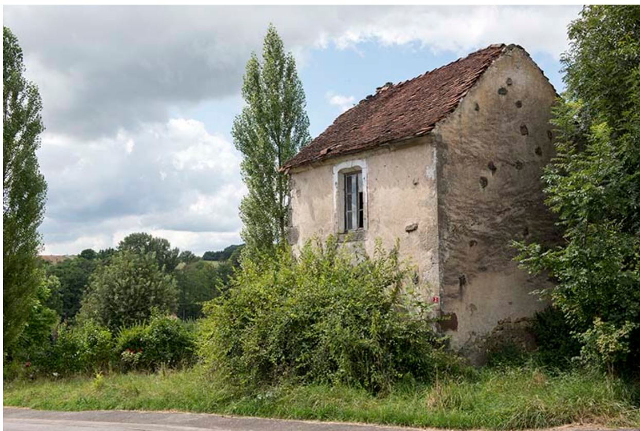
maison 2 rue du moulin
