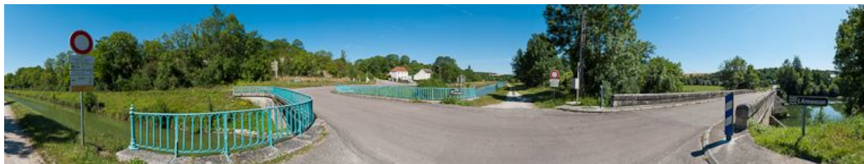
Vue d'ensemble du pont sur le canal et du pont sur l'Armançon.
