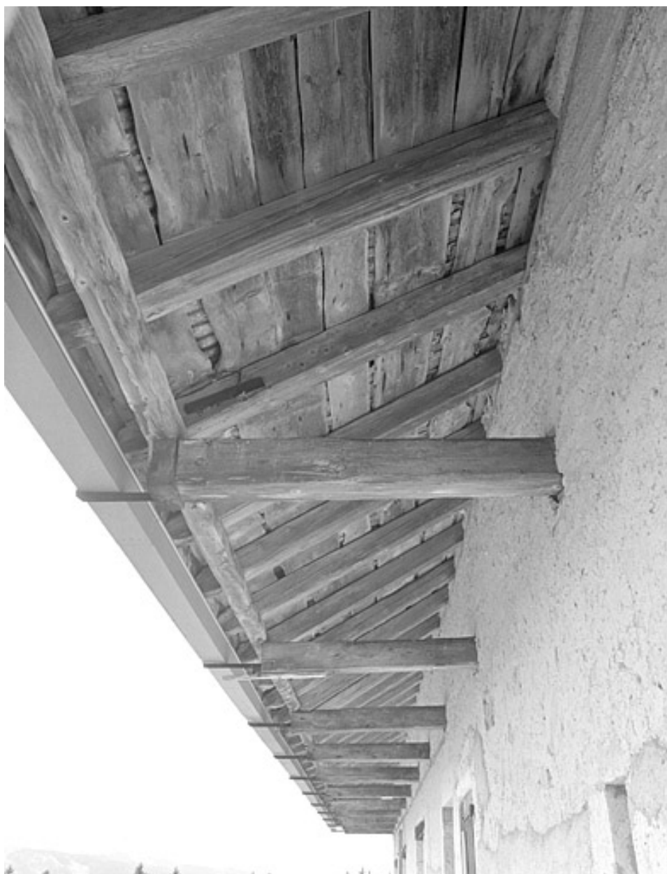
Détail de la charpente de l'avant toit.
