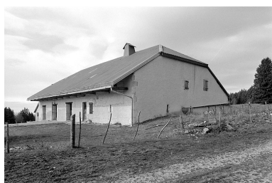
Façade antérieure et face nord-est. Phot. Jérôme Mongreville IVR43_19963901515X
