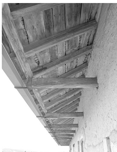
Détail de la charpente de l'avant toit. Phot. Jérôme Mongreville IVR43_19963901510X
