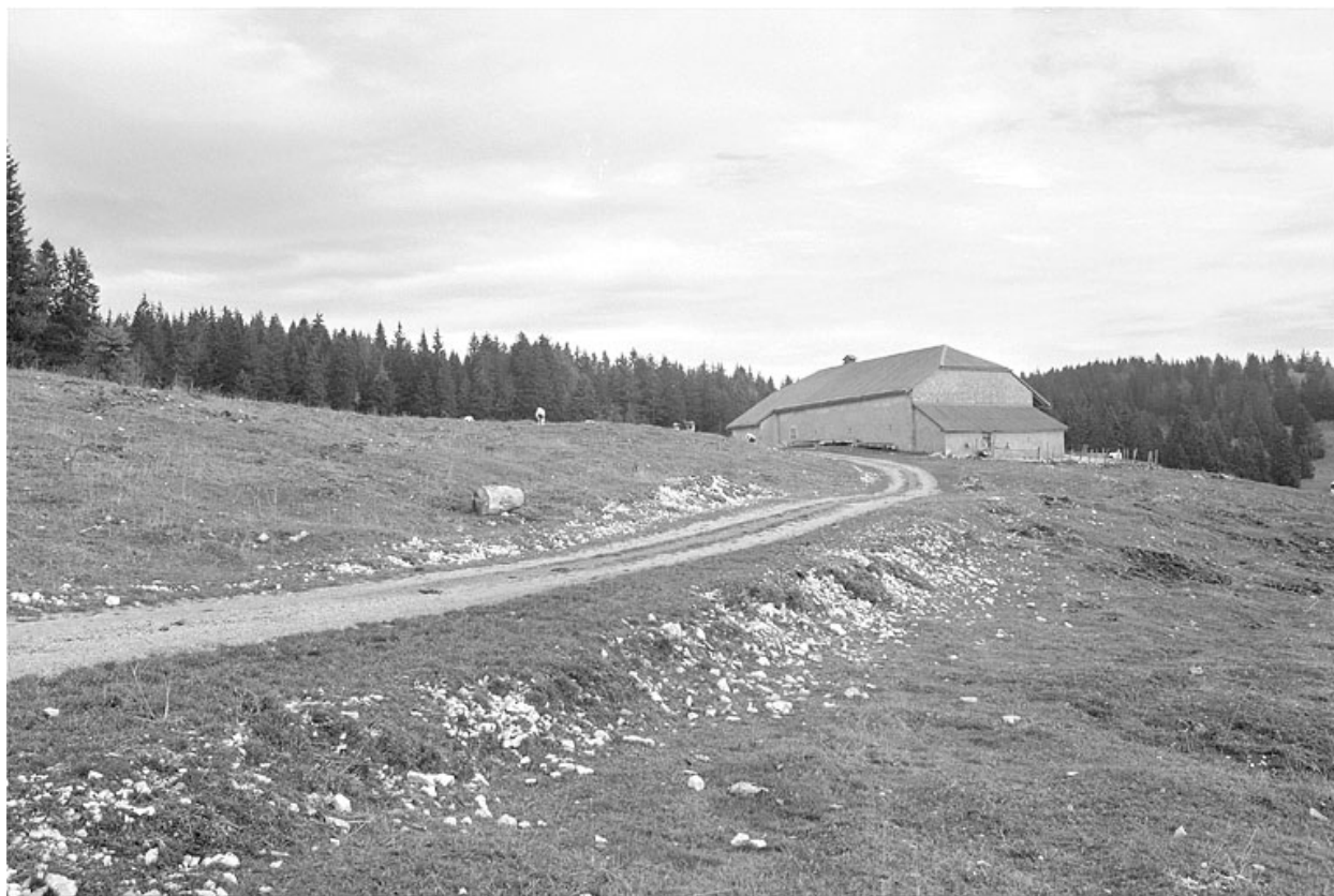
Vue générale depuis le chemin d'accès.
