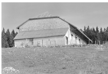
Face sud-ouest. Phot. Jérôme Mongreville IVR43_19963901514X
