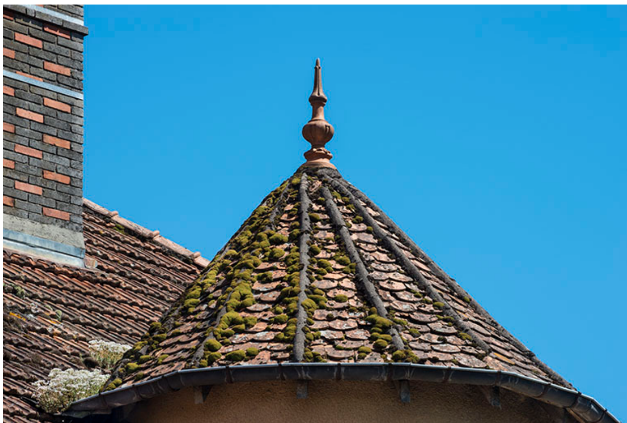
Toit conique nervuré de la tour demi-hors-œuvre.
