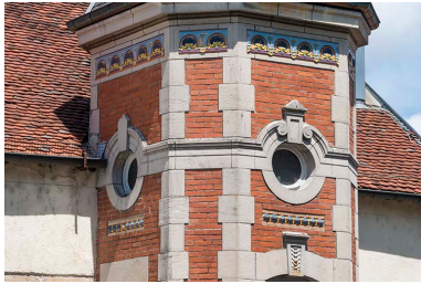
Partie supérieure de la tourelle percée d'oculis. Phot. Jérôme Mongreville IVR43_20177001026NUC4A
