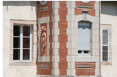
La tourelle au niveau de l'étage carré. Phot. Jérôme Mongreville IVR43_20177001025NUC4A
