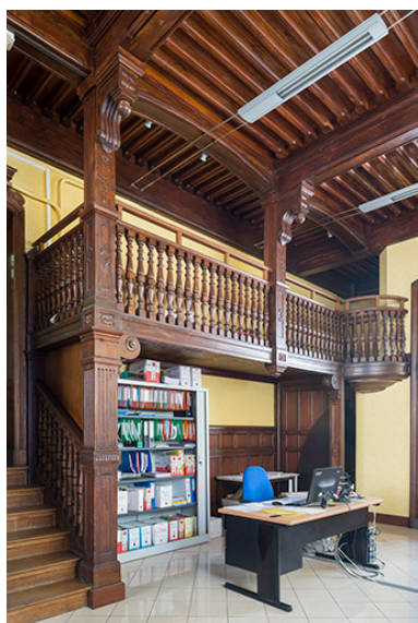
La mezzanine et sa balustrade. Phot. Jérôme Mongreville IVR43_20177000858NUC4A
