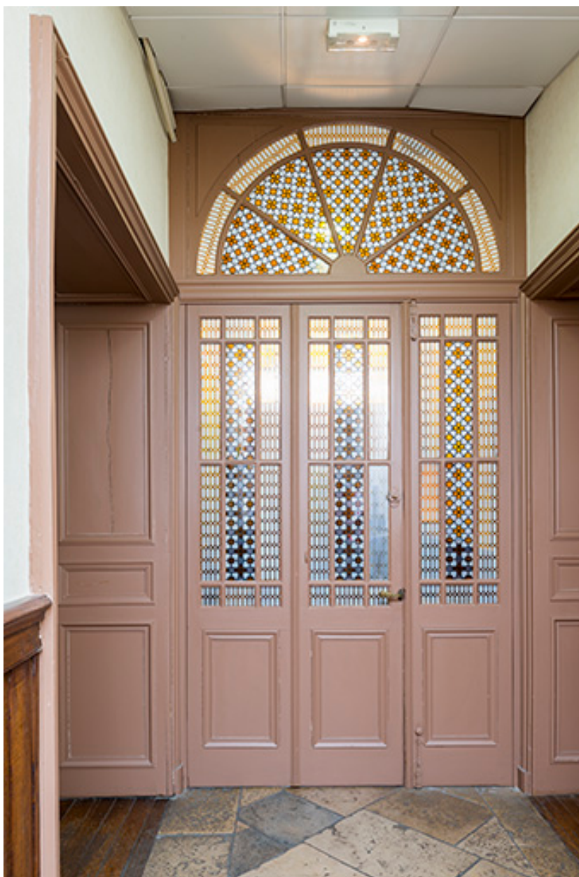
Porte intérieure vitrée du vestibule.
