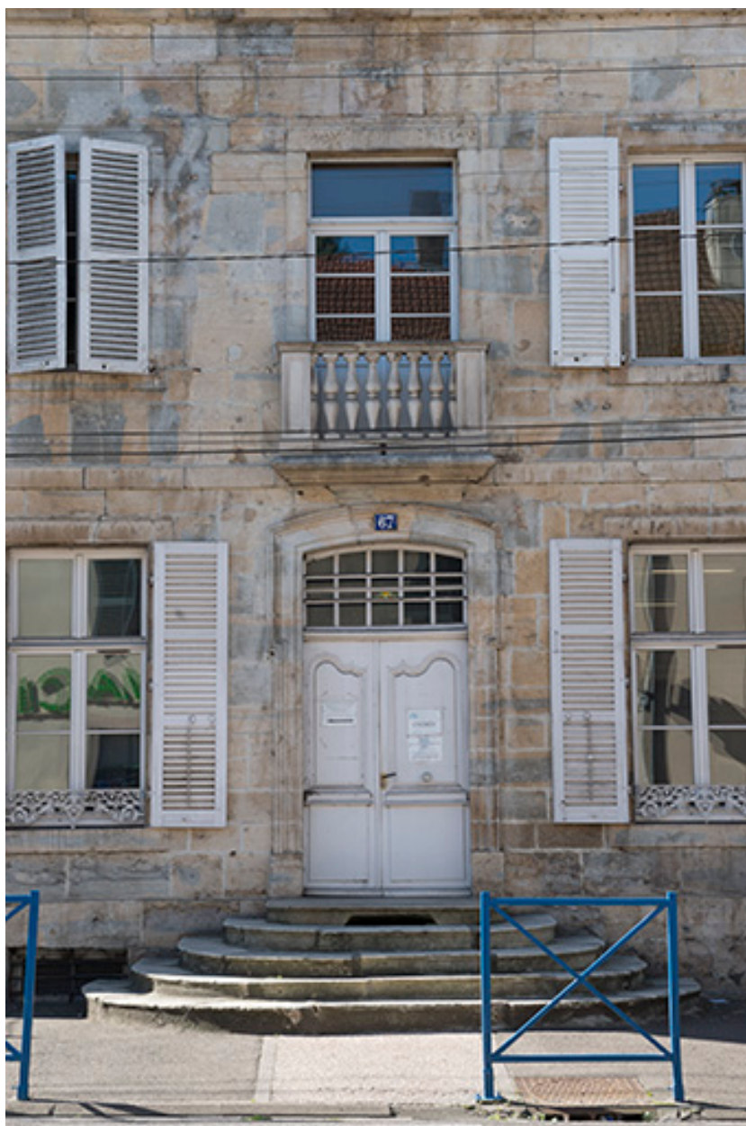
Vue de la travée principale, façade antérieure.
