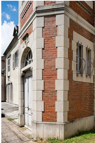
Base de la tourelle avec jeux de chainages en pierre de taille. Phot. Jérôme Mongreville IVR43_20177001028NUC4A
