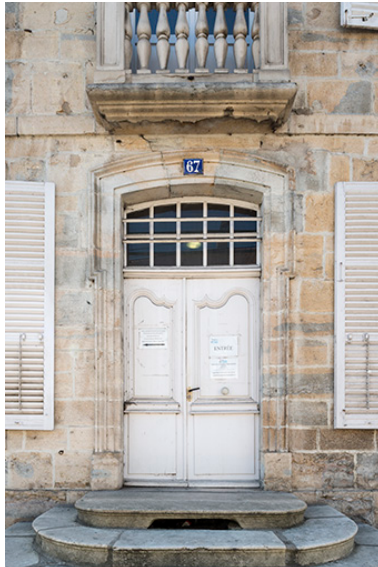
La porte d'entrée. Phot. Jérôme Mongreville IVR43_20177001036NUC4A
