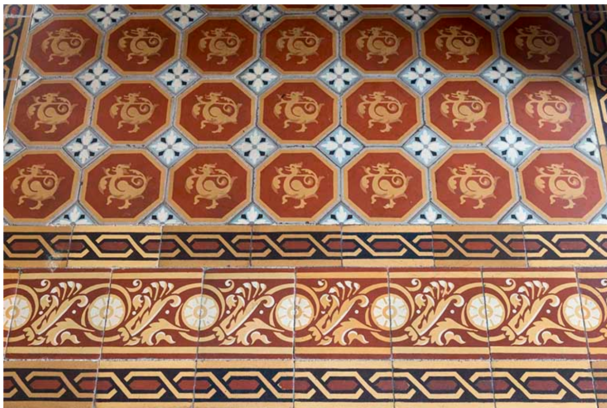
Le carrelage du foyer de la cheminée.
