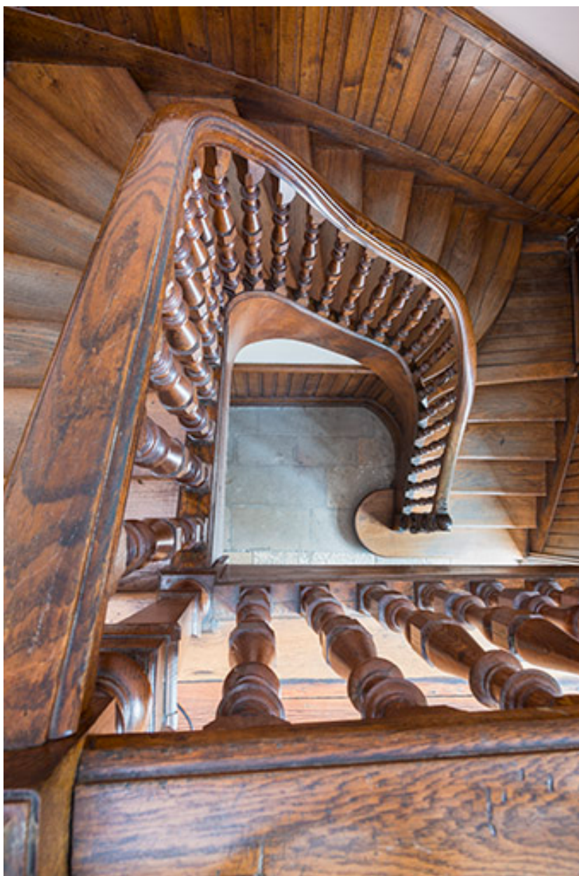
L'escalier à deux quarts tournant.
