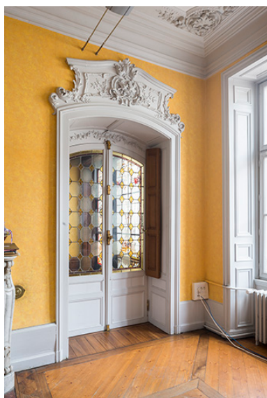
Porte-fenêtre du grand salon. Phot. Jérôme Mongreville IVR43_20177000869NUC4A
