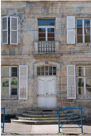
Vue de la travée principale, façade antérieure. Phot. Jérôme Mongreville IVR43_20177001033NUC4A
