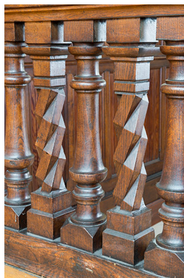
Détail des balustres carrés. Phot. Jérôme Mongreville IVR43_20177000863NUC4A
