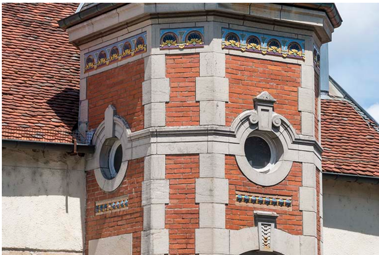
Partie supérieure de la tourelle percée d'oculis.
