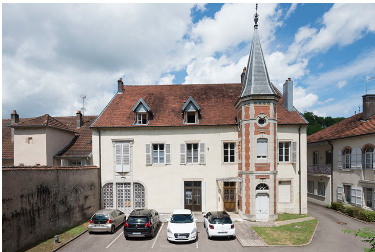
La façade postérieure.
