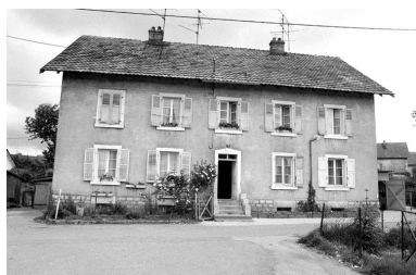
Maison ouvrière à quatre logements en 1980. Phot. Bernard Lardière IVR43_19809000072Z
