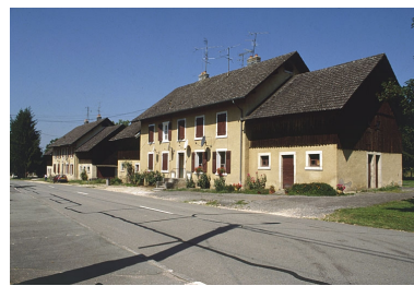
Logements collectifs route de Boron. Phot. Yves Sancey IVR43_20019000277ZA
