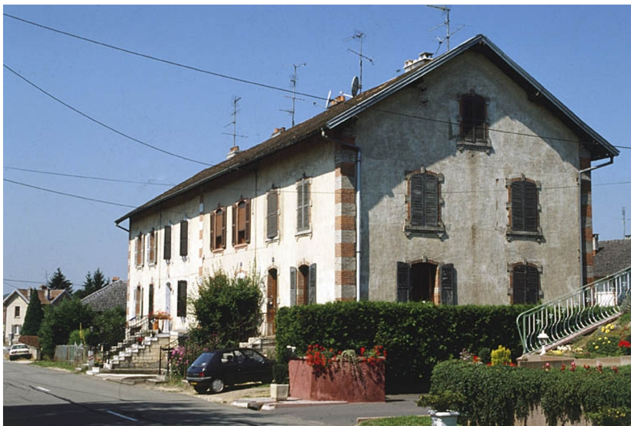
Maison à logements multiples route de Boron.
