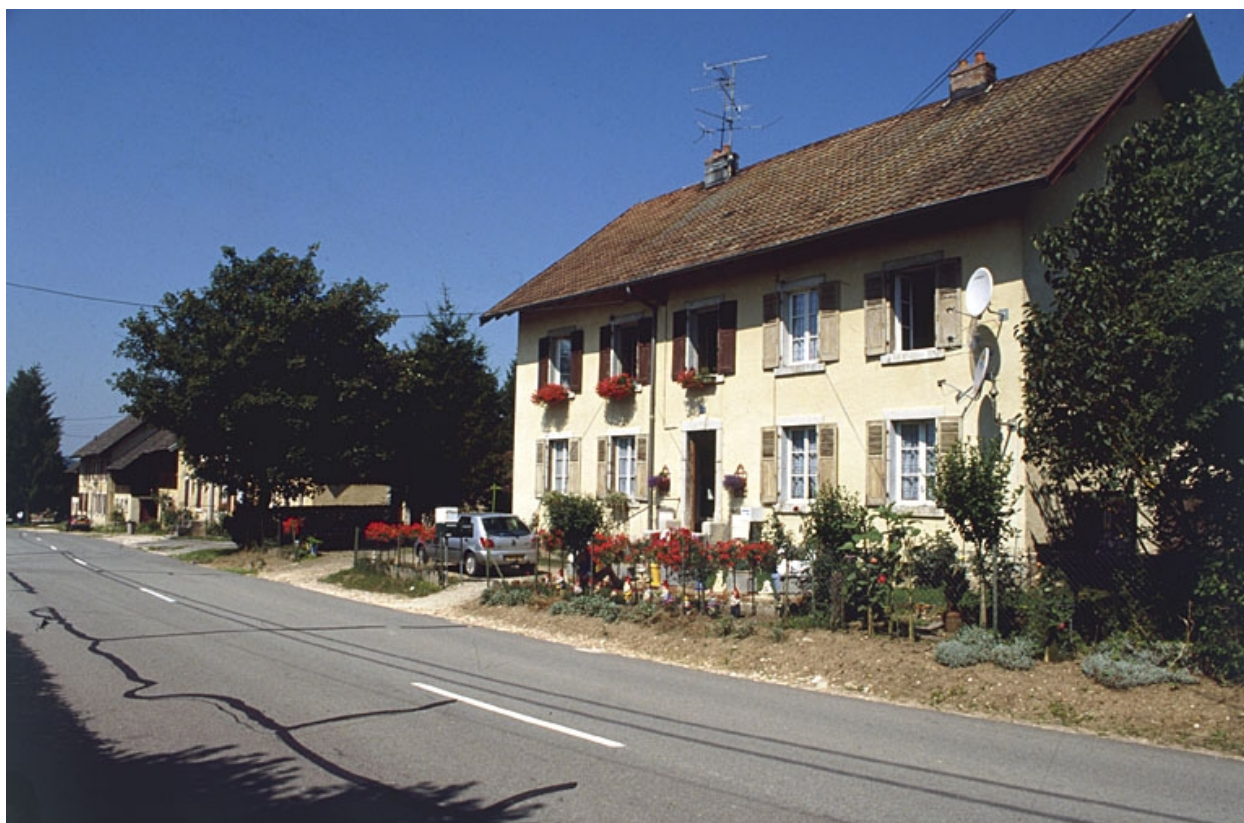
Maison à quatre logements route de Boron.
