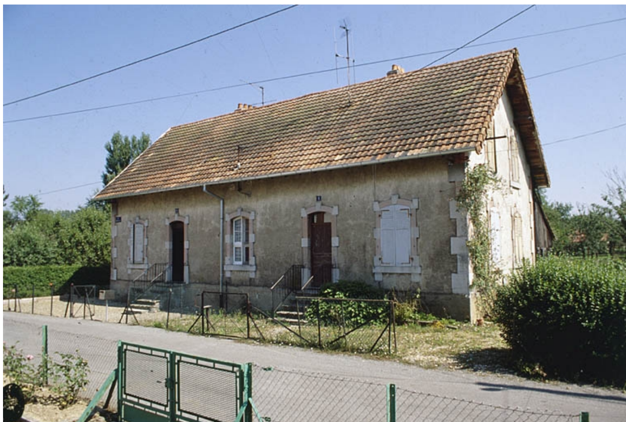
Maison à deux logements rue Rossat.
