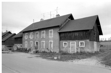
Logement ouvrier et dépendances en 1980. Phot. Bernard Lardière IVR43_19809000069Z
