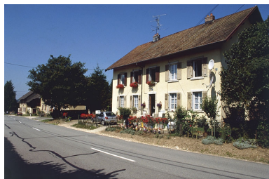
Maison à quatre logements route de Boron. Phot. Yves Sancey IVR43_20019000275ZA
