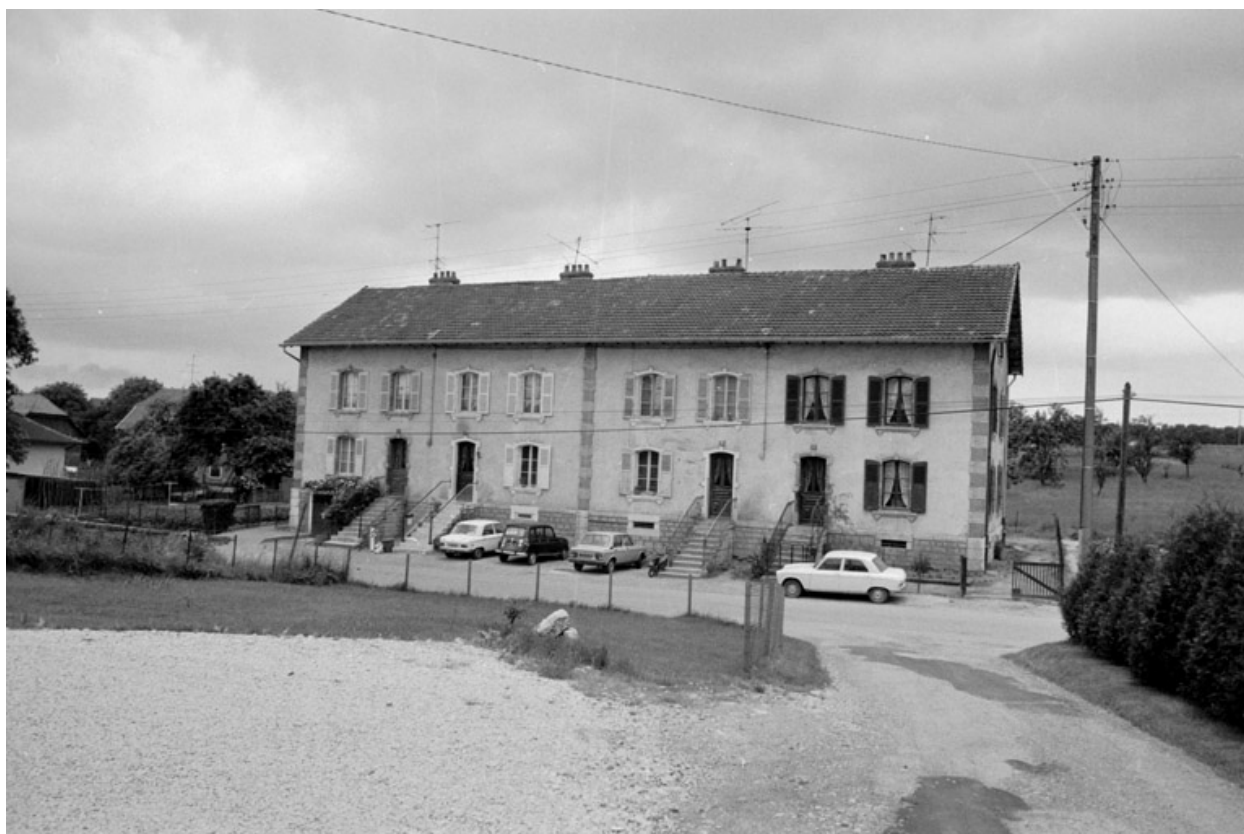
Logement ouvrier collectif en 1980.
