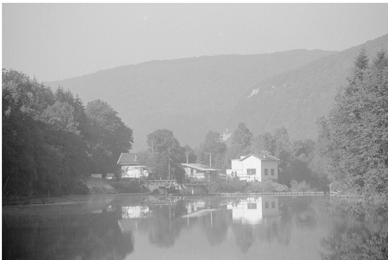
Vue d'ensemble, depuis l'amont.
