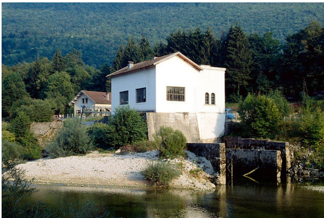
Façades postérieure et latérale gauche.
