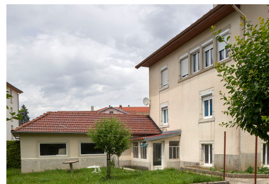
Façade postérieure et garage. Phot. Sonia Dourlot IVR43_20152500936NUC2A
