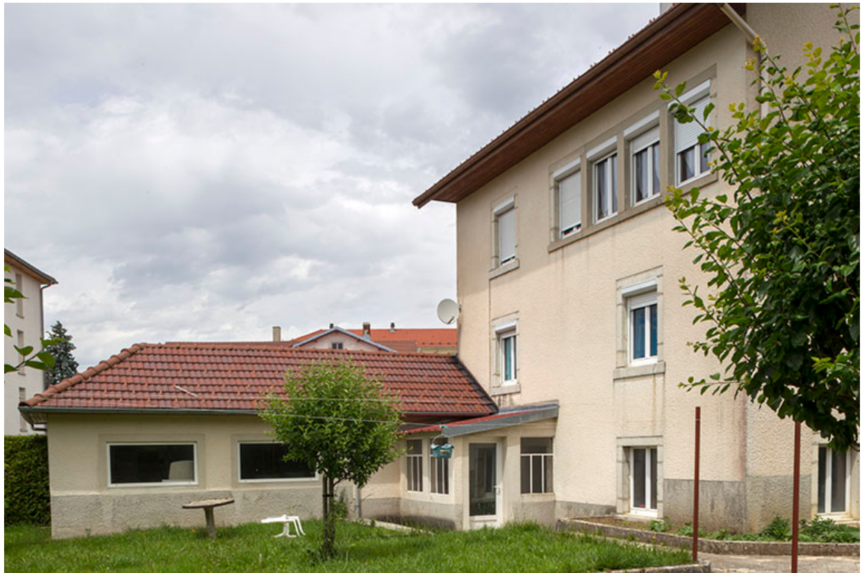
Façade postérieure et garage.
