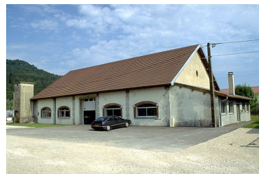
Atelier de fabrication (travail du bois). Phot. Yves Sancey IVR43_19973901336ZA
