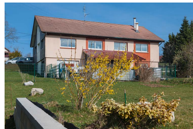
Usine : façade postérieure. Phot. Jérôme Mongreville IVR43_20142500295NUC4A
