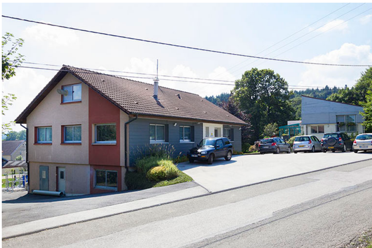
Usine : façade antérieure.
