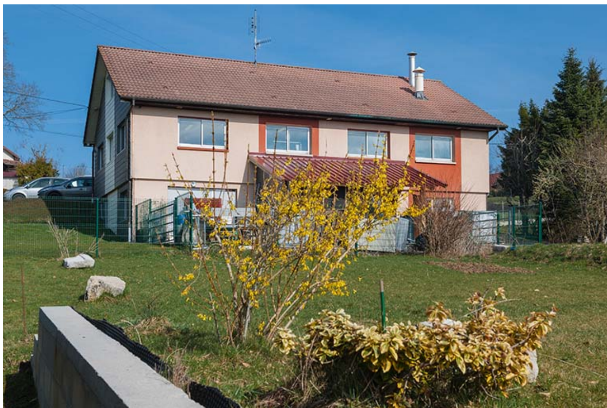
Usine : façade postérieure.
