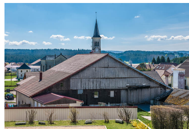
Ferme : façade postérieure. Phot. Jérôme Mongreville IVR43_20142500307NUC4A
