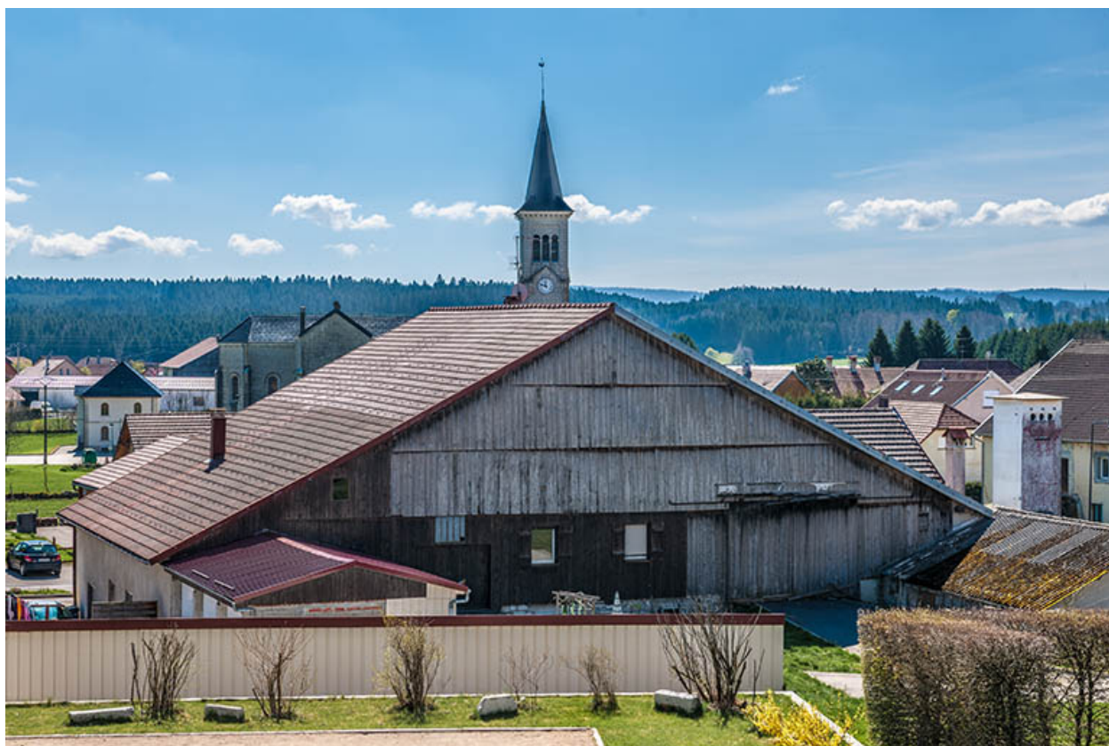
Ferme : façade postérieure.
