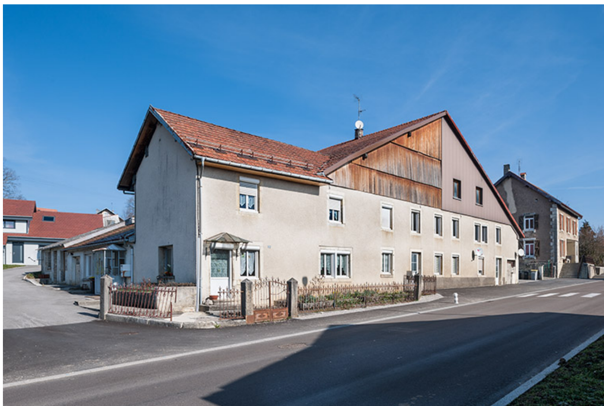
Ferme : façade antérieure, de trois quarts gauche.
