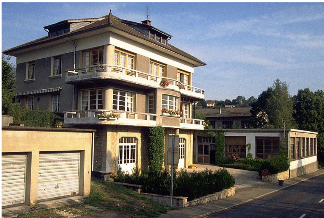
Logement patronal et atelier de fabrication (tournerie).
