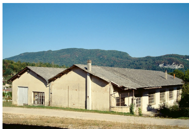
Atelier de fabrication (scierie), vu depuis l'ouest. Phot. Laurent Poupard IVR43_19913901003ZA
