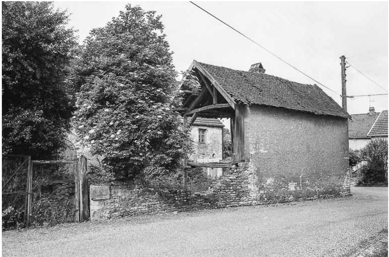
Façade postérieure de la remise.
