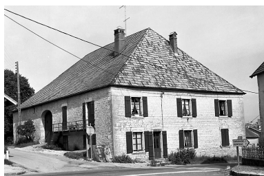
Ferme située Grande Rue. Phot. Yves Sancey IVR43_19802500946X
