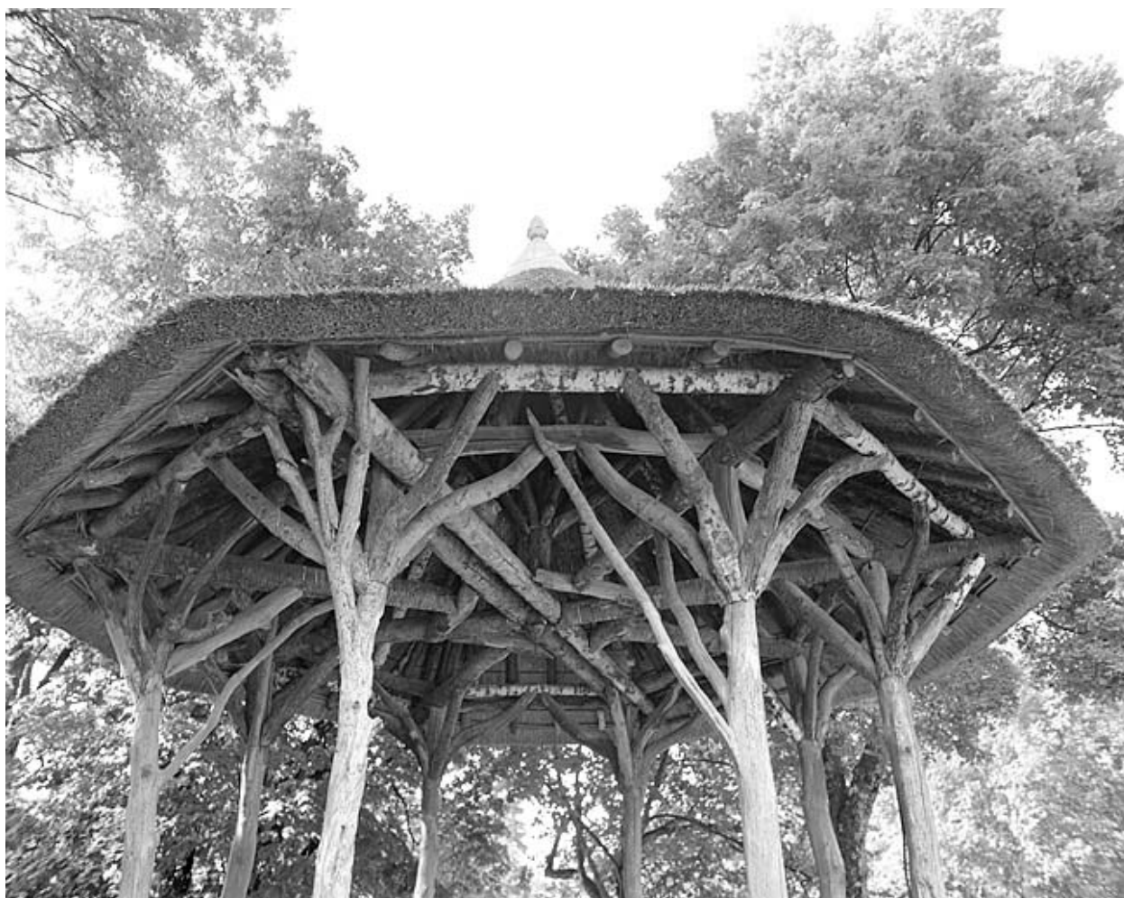
Vue du kiosque d'origine avant sa destruction en 1984, détail de la charpente.
