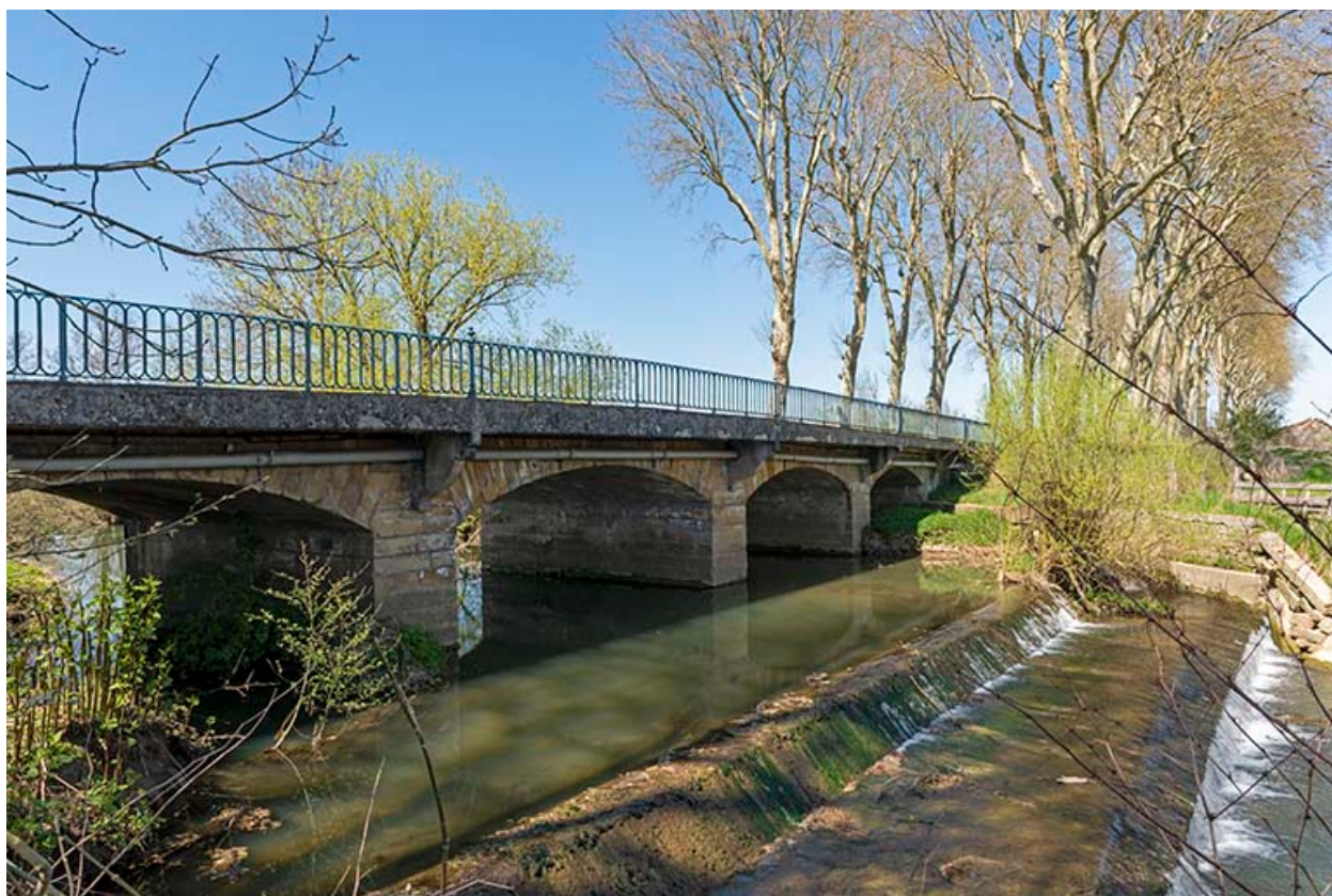
L'ensemble du pont, vu de l'est.
