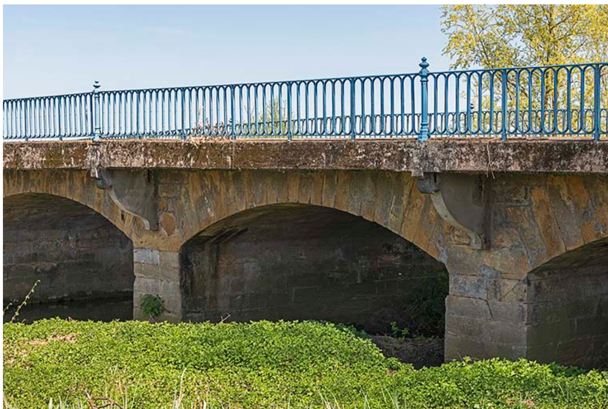
Les arches du pont, depuis l'ouest.
