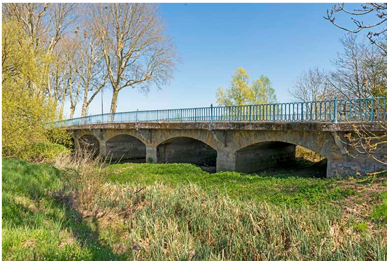
L'ensemble du pont, vu de l'ouest.
