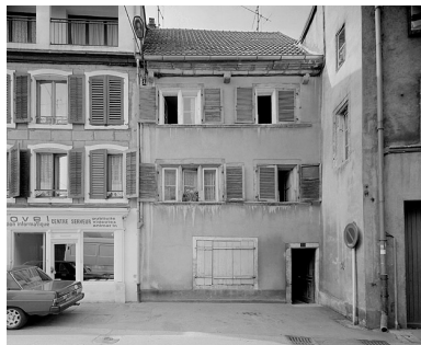
Façade sur rue. Phot. Jérôme Mongreville IVR43_19872501122V
